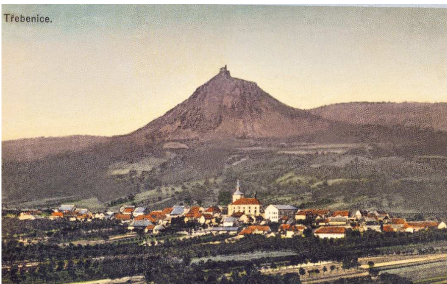
Foto 14.3.15. Třebenice (1905), vrch Košťál – jemně zrnitá mozaika zemědělské krajiny, políčka oddělená přístupovými cestami lemovanými dřevinným doprovodem, v pozadí plošně rozsáhlé ovocné sady na jižních svazích.
