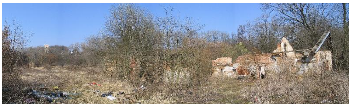
Obrázek 7. Úplně rozpadlý bývalý mlýn v Královicích, v současné době černá skládka
