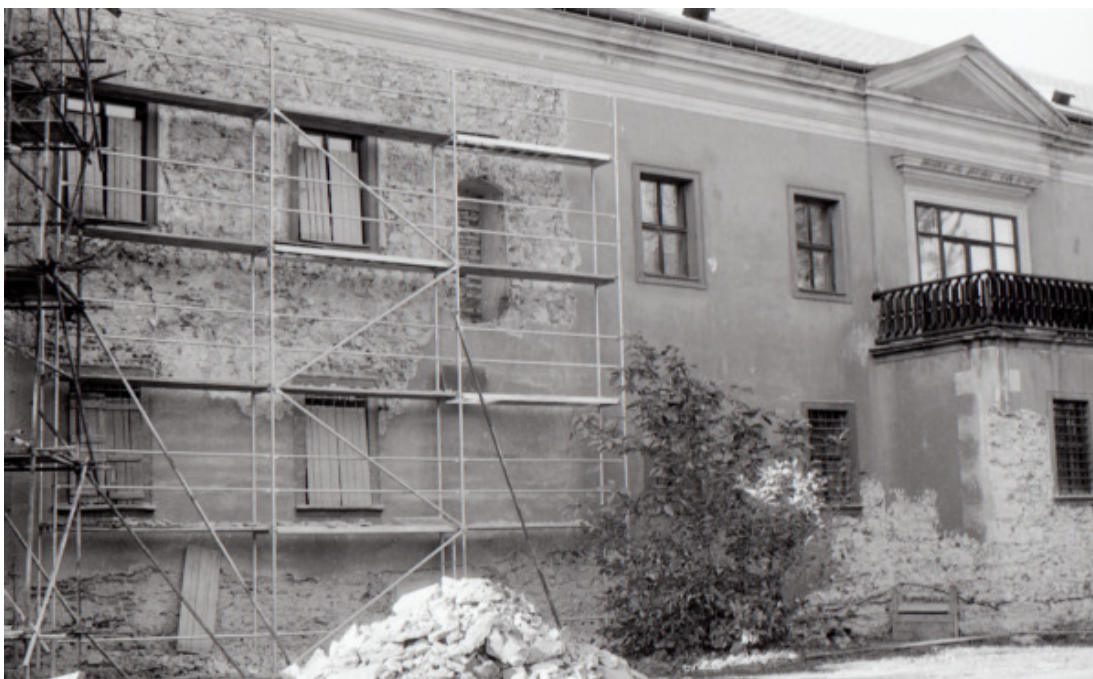
52. Vnější fasáda jižního křídla při opravě na podzim 1993 – odhalený vstup na pavlač ze šlikovské éry
