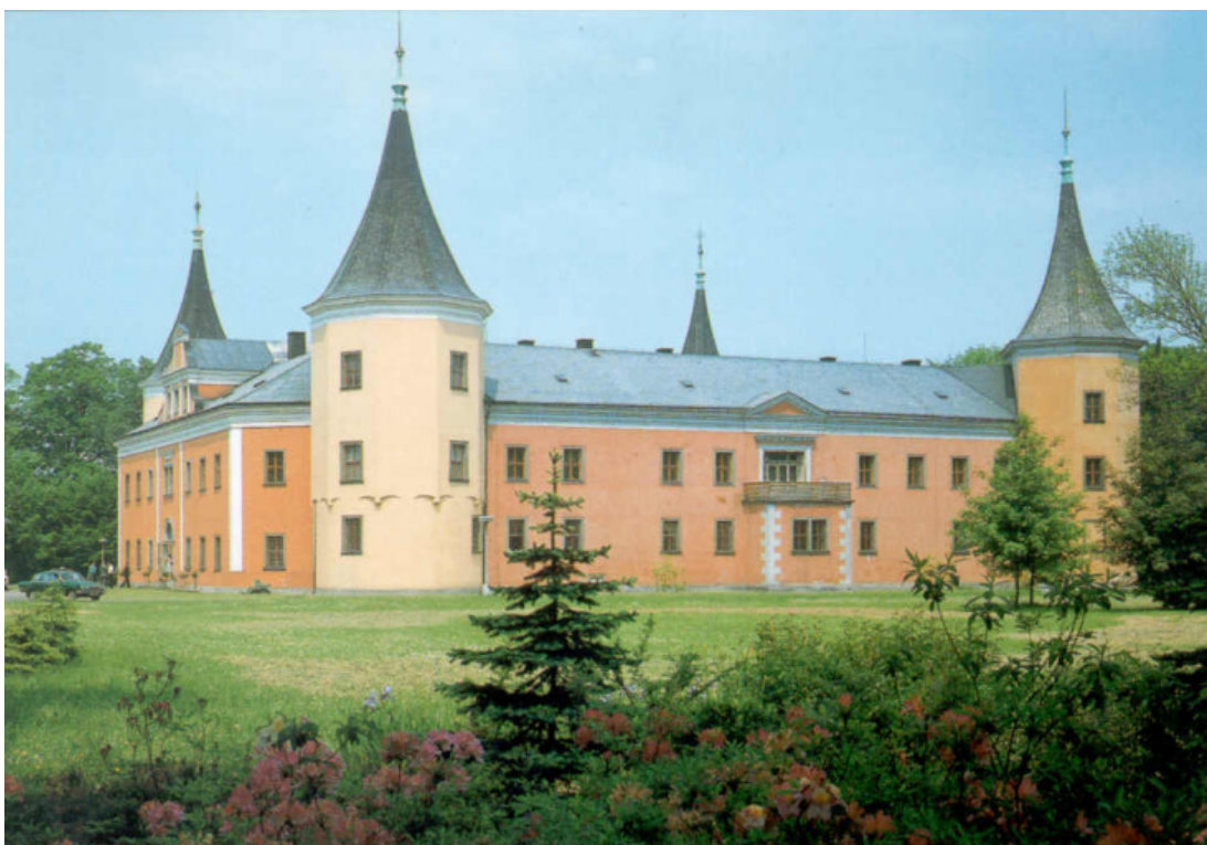
49. Zámek po opravě v 70. letech 20. stol.
