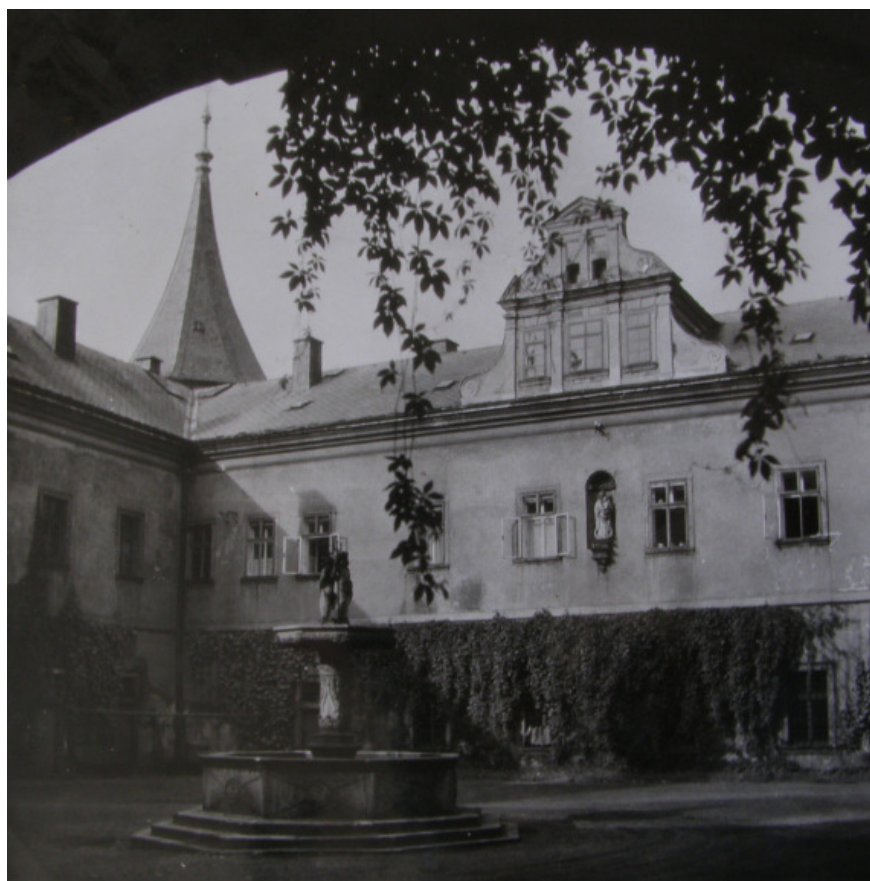
46. Pohled na východní křídlo zámku v roce 1947, v nice socha Panny Marie
