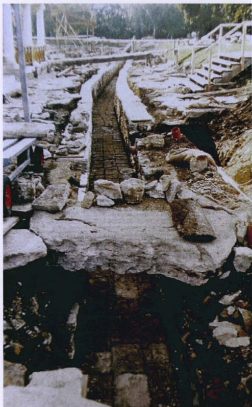
Obr. 41 Kanalizační systém pod severní ulicí, pohled od východu (Kandler, M. – Humer, F. – Zabehlicky, H. 2004; Abb. 23, s. 42)
