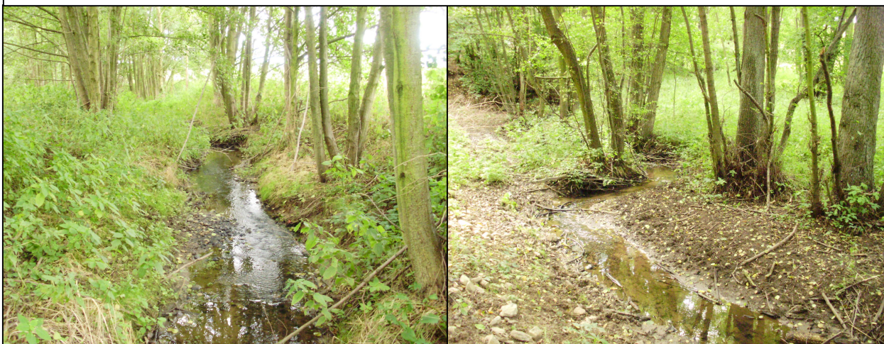
Foto 28, 29: Vlevo - první fáze rozvlnění toku po vyjmutí opevňujících kulatin, vpravo - vytvoření větších zákrutů po delší době
