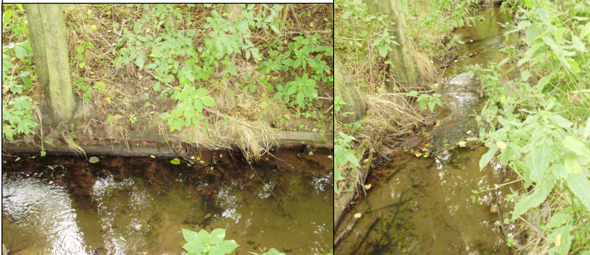
Foto 26, 27: Úseky K09, K10 - Napřímený, zahloubený tok Klíčavy, zpevněný kulatinou, příbřežní zónu tvoří neprostupná bujná vegetace, niva je zemědělsky využívána
