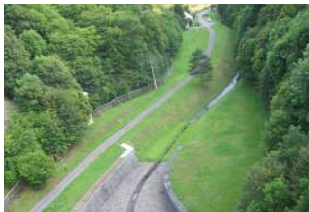
Foto 5: Úsek pod hrází údolní nádrže, IV. ES
