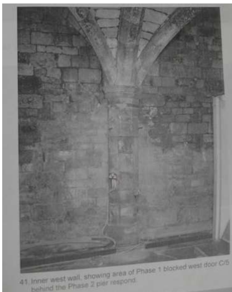
Obr. 16: Detail opěrného pilíře z druhé fáze výstavby, který byl umístěn proti západnímu vchodu prvního kostela minoritů v Lincolnu. Foto dr. Colin Hayfield. C. HAYFIELD, „A Conservation Plan“, Vol. 2, obr. 41, n. s.
