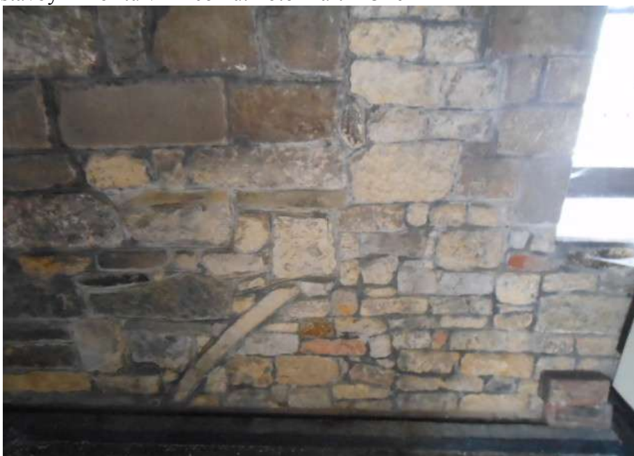
Obr. 12: Detail dochovaného fragmentu arkádového oblouku viditelného v patře stávající stavby minoritů v Lincolnu. Foto Martin Ollé
