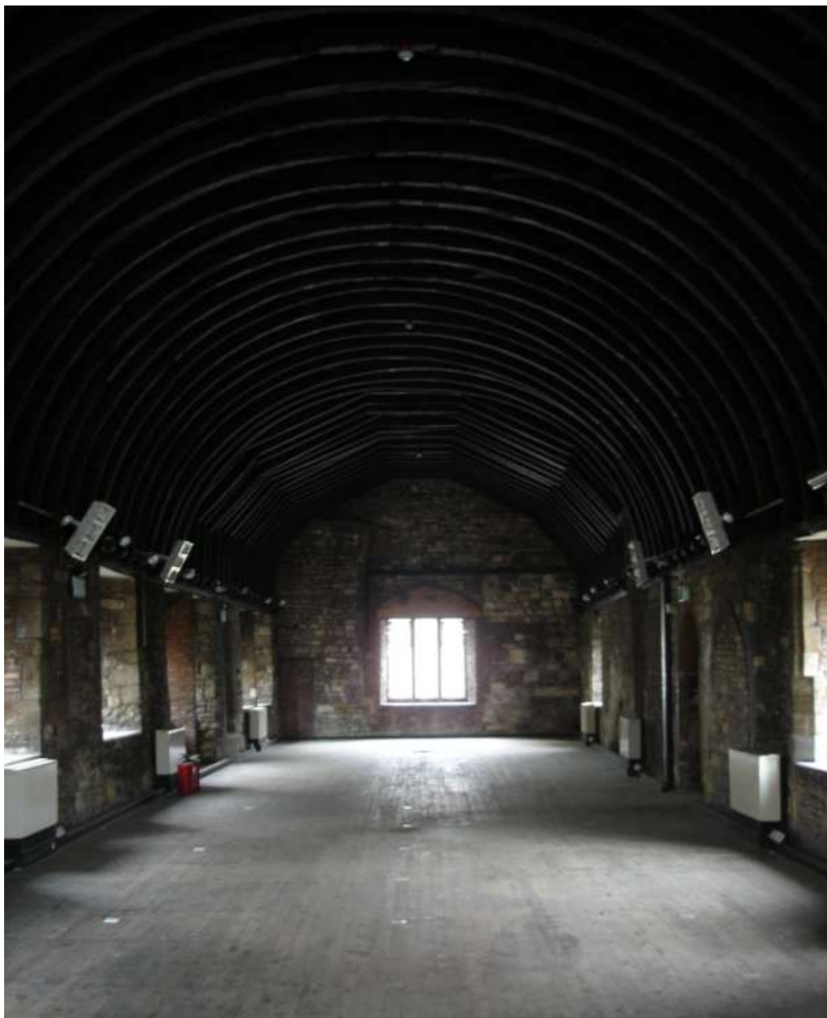
Obr. 10: Pohled na západ z pozdějšího patra dochované stavby minoritů v Lincolnu. Na snímku je patrná změna profilu střešních vzpěr na západním konci budovy, což je oblast uvažované lodě prvního kostela. Foto Martin Ollé
