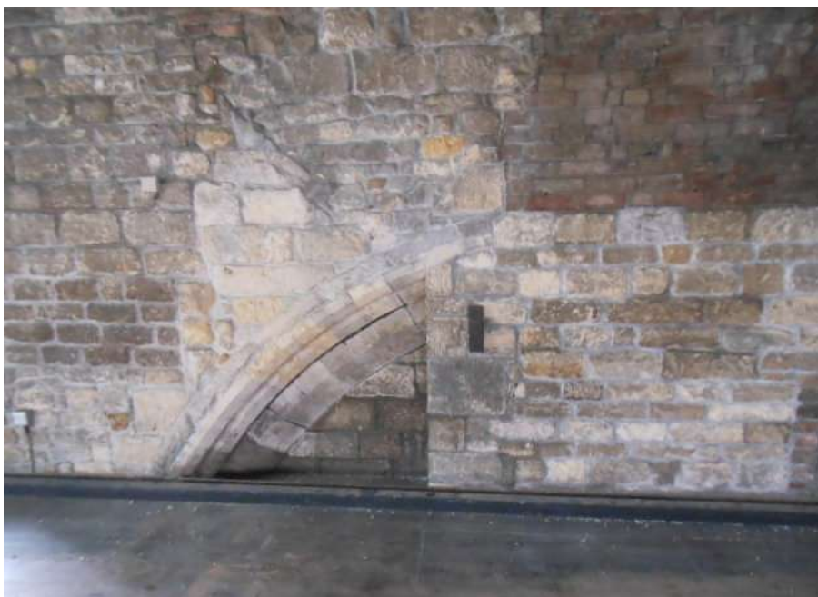
Obr. 12: Detail dochovaného fragmentu arkádového oblouku viditelného v patře stávající stavby minoritů v Lincolnu. Foto Martin Ollé
