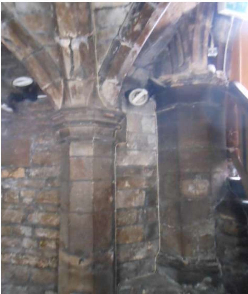
Obr. 11: V popředí jeden z pilířů nesoucích klenbu z doby přestavby prvního kostela po polovině 13. století. V pozadí pak dochovaný arkádový pilíř, který se otevíral do severní boční lodi (?). Foto Martin Ollé
