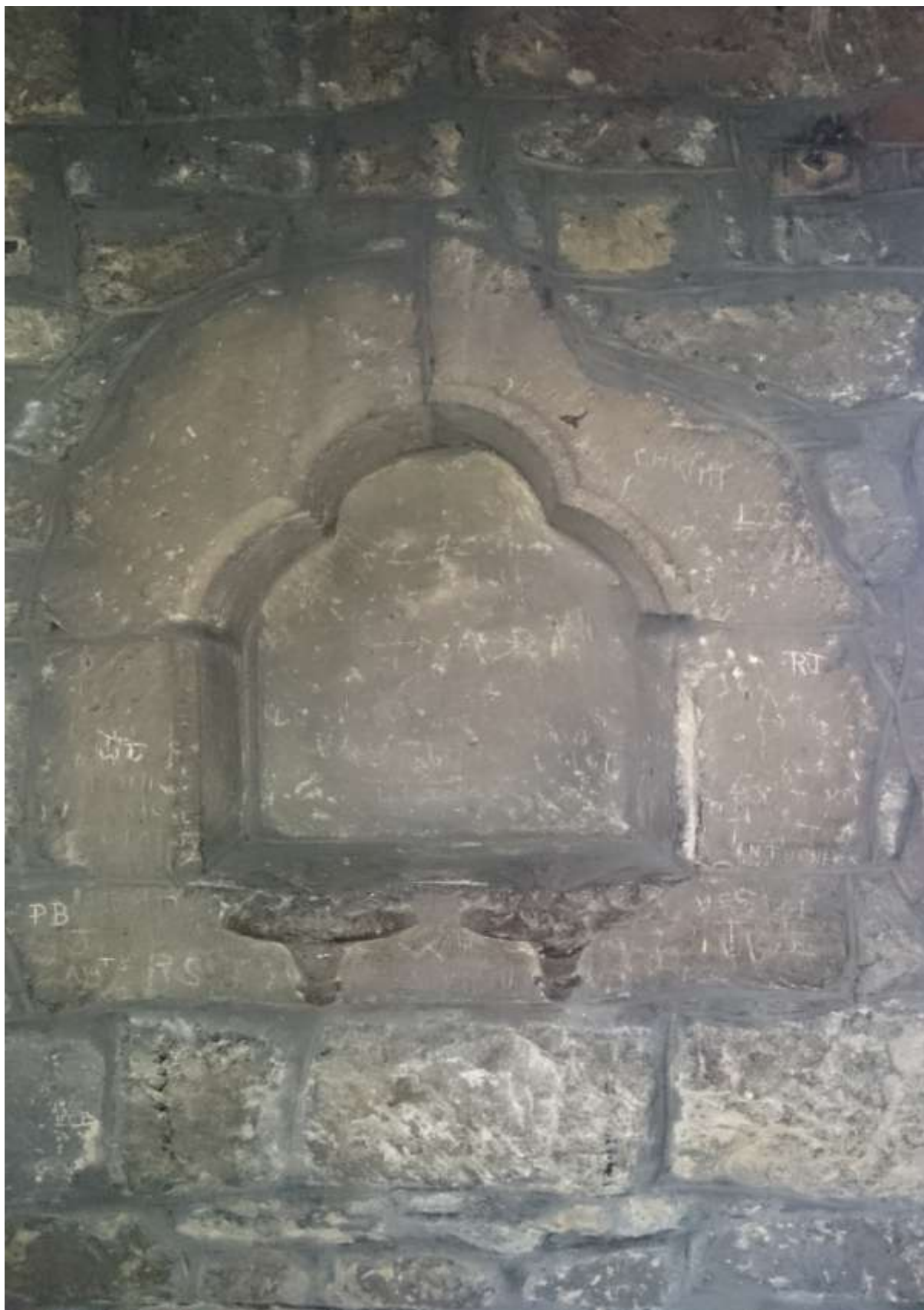
Obr. 14: Detail pisciny v patře dochovaného objektu lincolnských minoritů. Tento prvek je spojován s funkcí infirmaria celé stavby po druhé polovině 13. století. Foto City of Lincoln Council.
