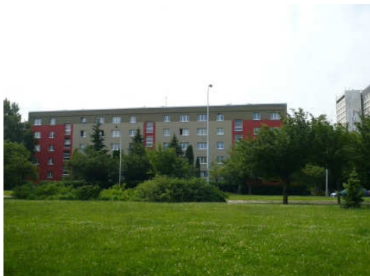
Obr. 2.2.3.3: Zdařilé provedení barevné fasády panelového domu, sídliště Rybníčky, ulice V Olšínách
