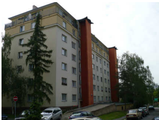
Obr. 2.2.3.2: Dostavba dvou pater a vnějších výtahů, sídliště Rybníčky, ulice Sečská
