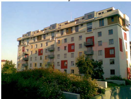
Obr. 2.2.3.1: Panelový dům na sídlišti Chmelnice po regenerace, ulice Pod Lipami
