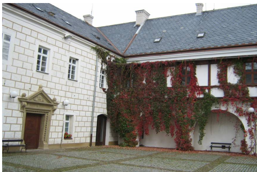
Obr. 29. Nádvoří zámku – loubinec ( Parthenocissus inserta )
