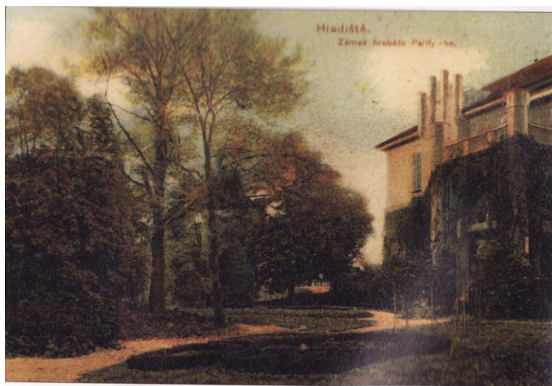
Obr.11. Fotografie východního průčelí s rizalitem nesoucím terasu (poč. 20. stol.)
