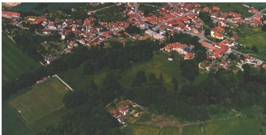
Obr. 5. Letecký pohled na zámek s parkem. V levém dolním rohu fotbalové hřiště, vpravo od něj okraj bažantnice.
