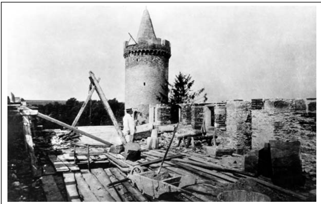
Obr. č. 12 Stavební práce na starém paláci probíhající v letech 1911-1913.
