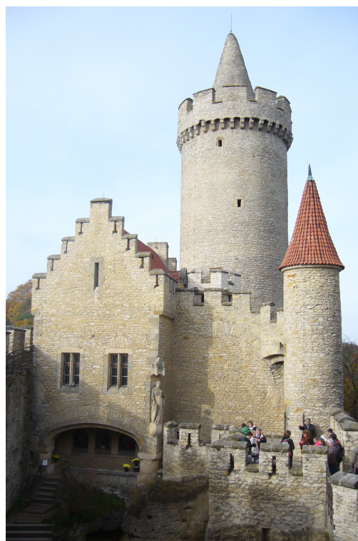
Obr. č. 22 Vnitřní nádvoří s novou budovou a původní gotickou věží.
