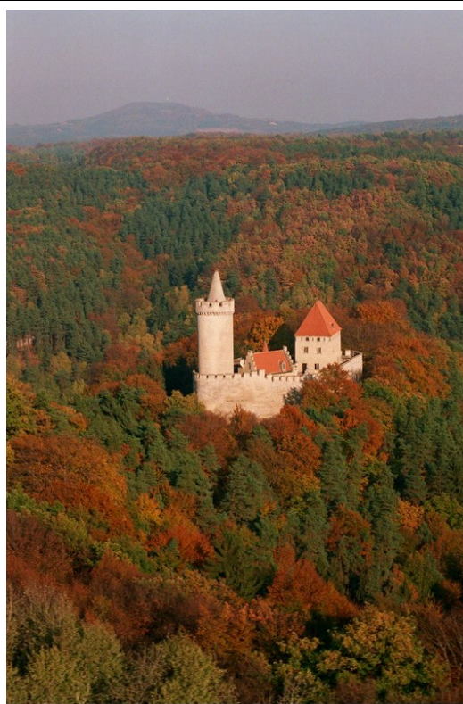
Obr. č. 37 Letecký pohled na hrad od jihozápadu.
