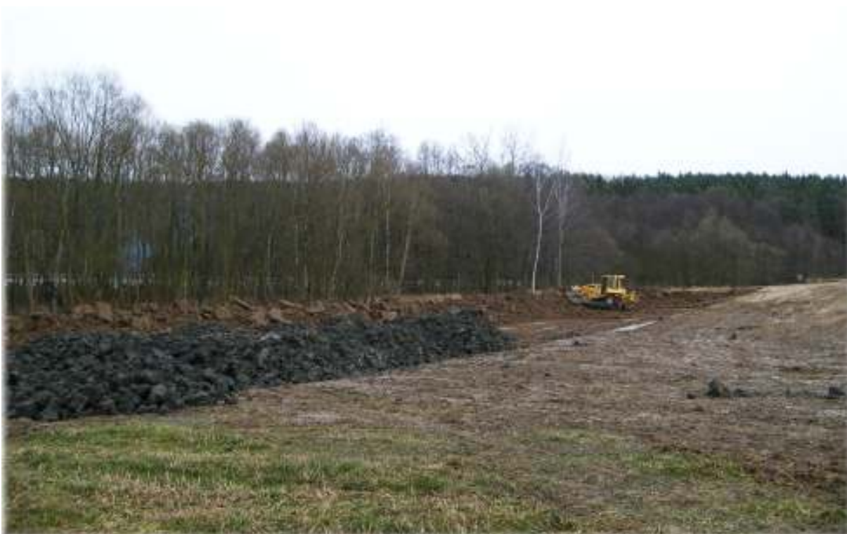
Obr. 38. Zavážení lokality „Hofacker“ vybagrovaným materiálem z čištěného rybníka.
