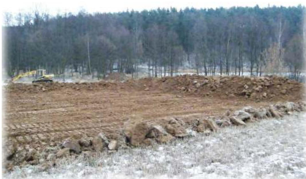
Foto: Lokalita „Hofacker“ po neoznamené skrývce ornice a části podorniční vrstvy 9.1.2009. Pohled od SZ.
