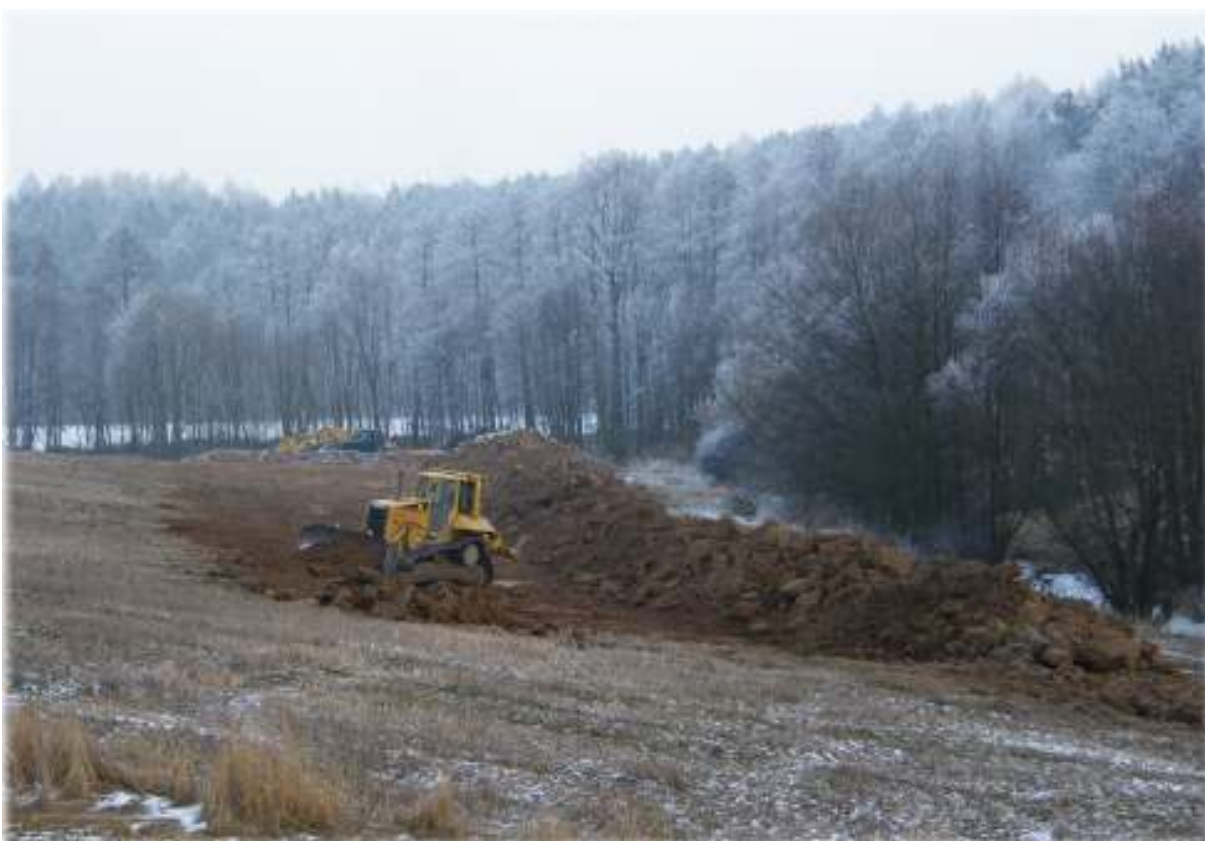
Obr. 37. Zemní práce na lokalitě v poloze „Hofacker“
