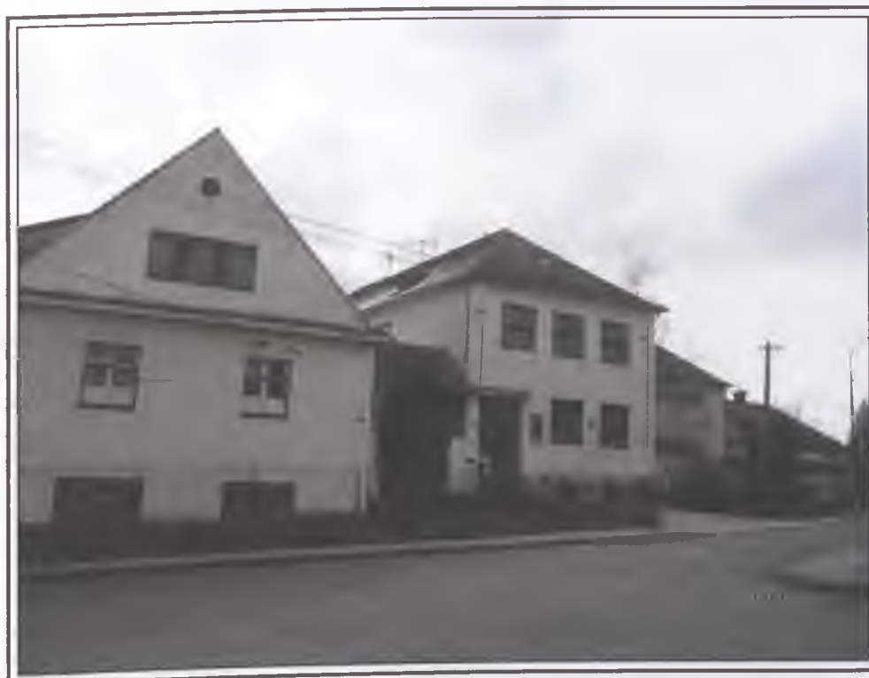
VIII. 28. Komplex budov bítovské školy
