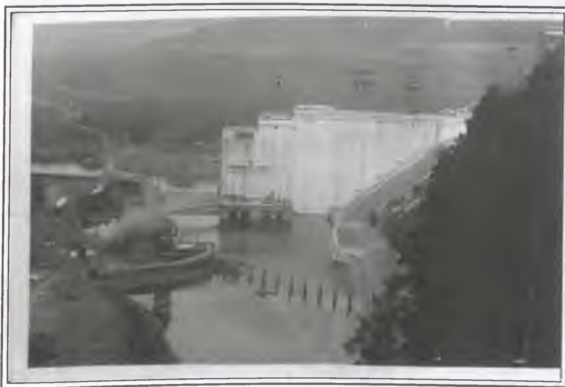
VIII. 16. Pohled na stavbu vranovské hráze
