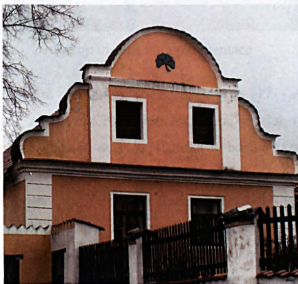
Obr. č. 30: Štít stavení č.p. 11
