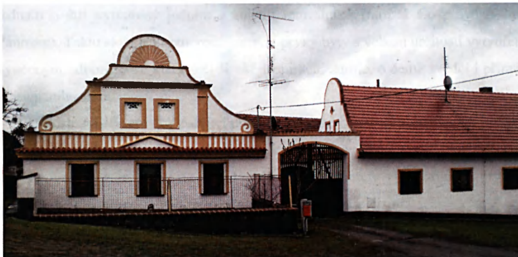
Obr. č. 32: Stavení č.p. 17
