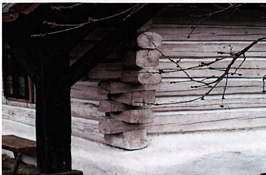
Obr. č. 20: Nárožní vazba stavení č.p.120
