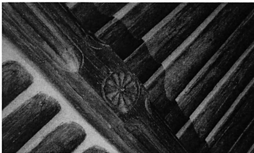
Obr. č. 5: Hraněná stropnice, s vyřezávaným motivem, procházející pod kuláči
