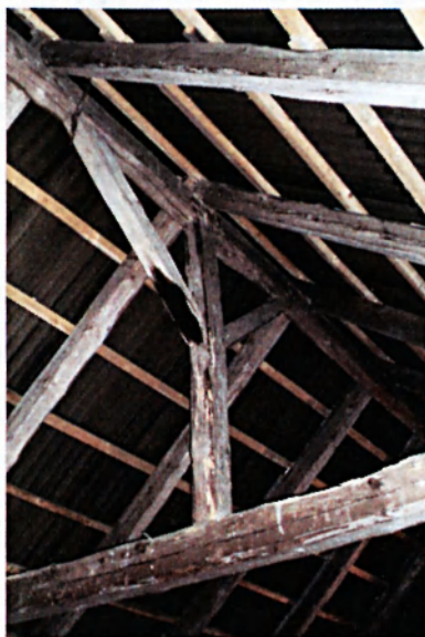
Obr. č. 8: Hřebenová vaznice
