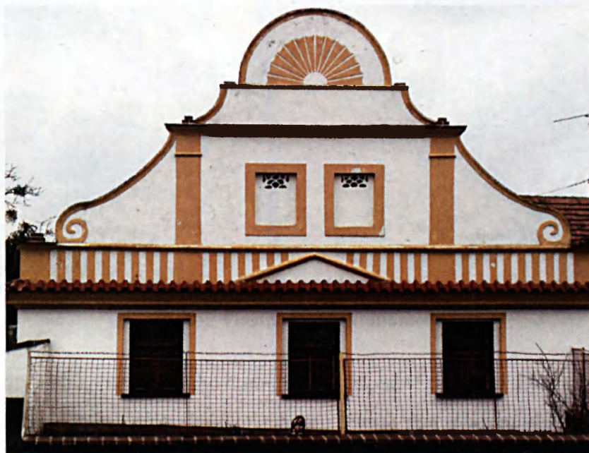
Obr. č. 33: Štít stavení č.p. 17
