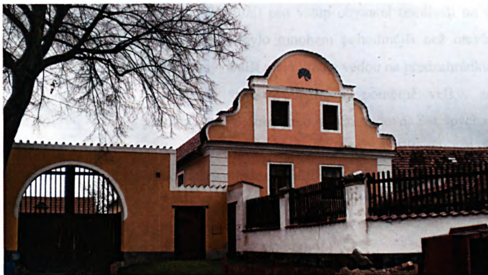
Obr. č. 29: Stavení č.p. 11
