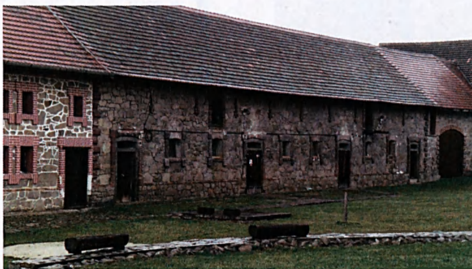
Obr. č. 38: Část dvora č.p.1/ Skály 67
