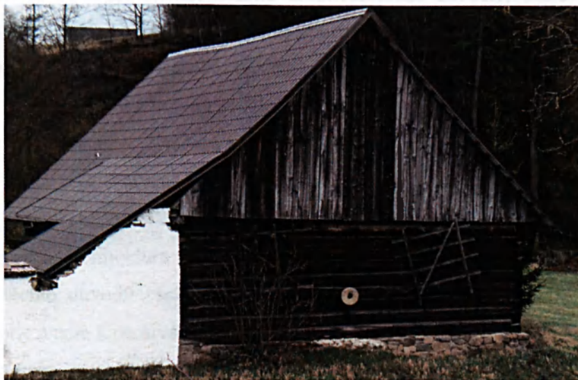
Obr. č. 23: Boční pohled na stodolu č.p. 127
