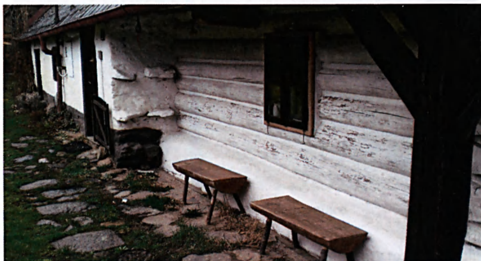
Obr. č. 21: Boční pohled na stavení č.p. 120
