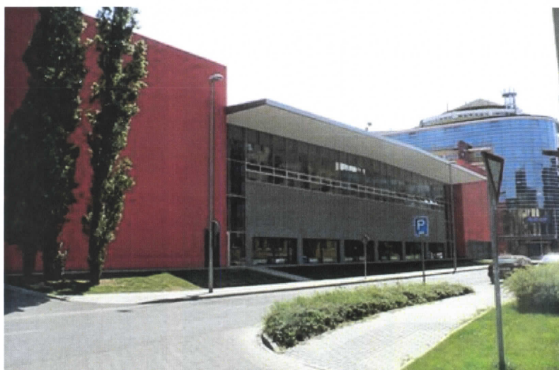
Nová multifunkční hala AC Sparta Praha ve Vysočanech
