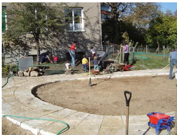
Obrázek č. 16: Rekonstrukce venkovních prostor
