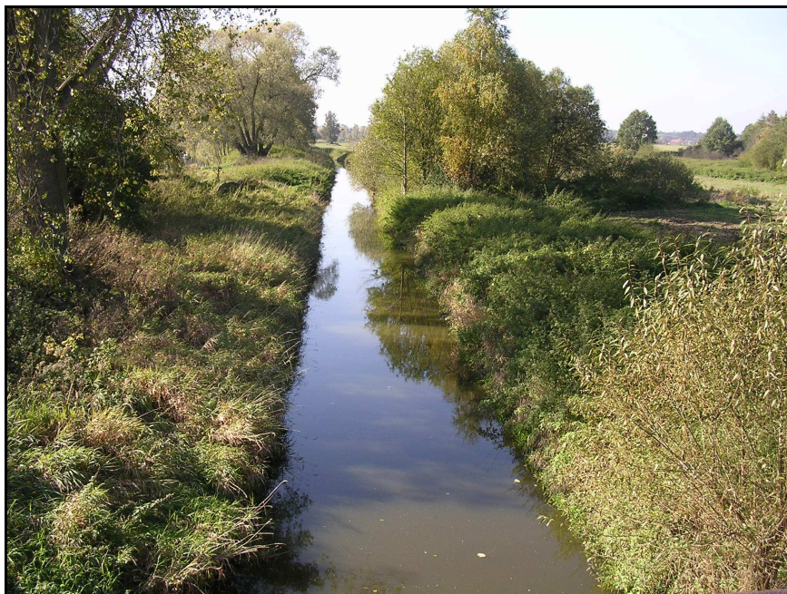
Obrázek č. 17: Napřímené koryto na toku Lomnici 2 km jižně od Blatné. (Foto: Bažatová 2007)
