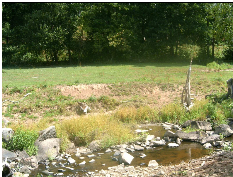
Obrázek č. 33: Břehová nátrž u obce Dolní Ostrovec (Foto: Bažatová 2008)
