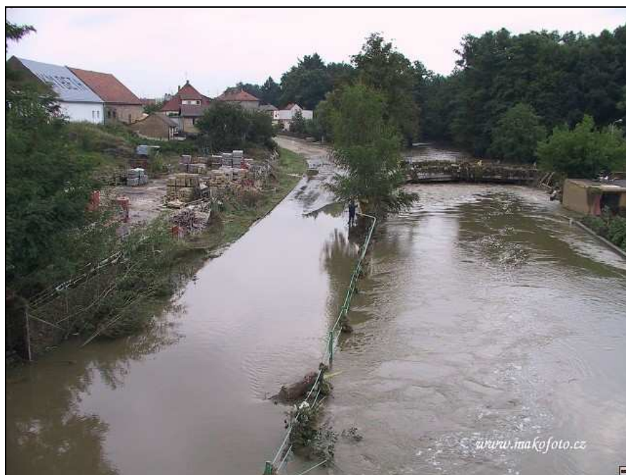
Obrázek č. 12: Rozliv vody při povodni 2002 u Nohavického mostu v Blatné (Zdroj: http://www.makofoto.cz/Foto/Ostatni/povoden_2002 )
