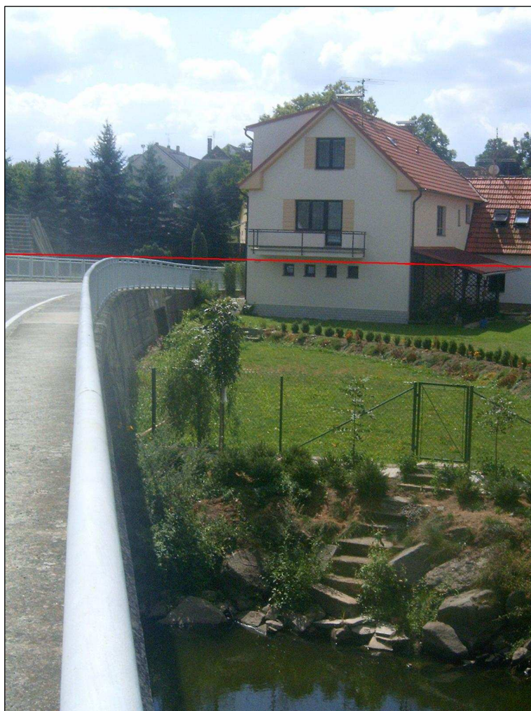
Obrázek č. 29 : Nově rekonstruovaný dům v obci Dolní Ostrovec. Červená linie ukazuje výši vody při povodni 2002 – dle povodňové značky (Foto: Bažatová 2007)
