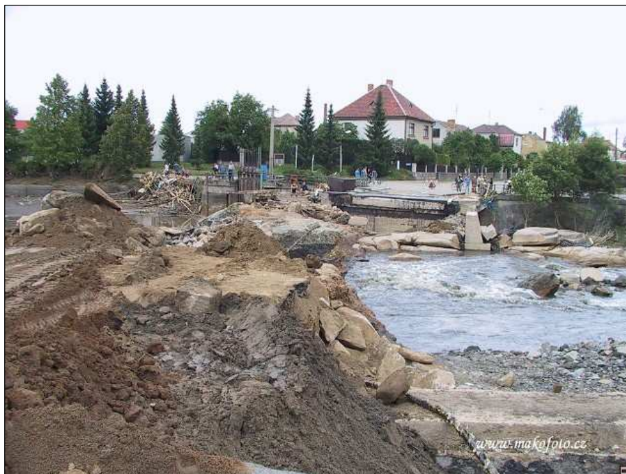
Obrázek č. 13: Zničená hráz rybníka Pustý a komunikace při povodni 2002 (Zdroj: http://www.makofoto.cz/Foto/Ostatni/povoden_2002 ).
