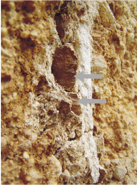
Obr. č. 26: Zlomová porucha na lokalite Za kláštorom. Pohyb na zlome dokumentujú žliabky v ílovej výplni a biela brekciovitá výplň. Foto: Bristenský.
