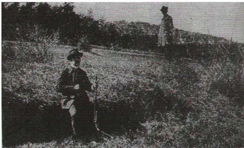
Obr. č. 38: Terénny stupeň generovaný pri zemetrasení v januári 1906. Jav bol situovaný 1,5 km juhozápadne od obce Dobrá Voda. Foto: Archív GFÚ AV SR.
