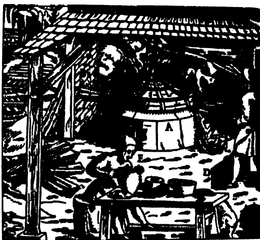
Obr.4: Sháněcí pec pro výrobu stříbra (Agricola, 1556)
