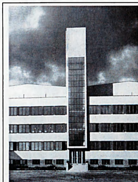
Obr. č. 45 Hlavní budova se středovou věží, v níž je umístěný vodojem.
