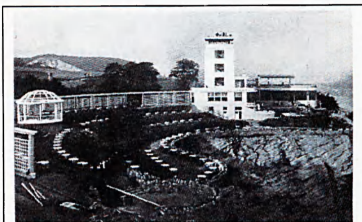
Obr. č. 2 Pohled na budovu restaurace Terasy z Trilobit baru. Po levé straně je vidět hudební altán.
