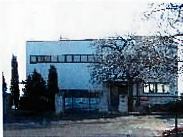
Obr. č. 30 Čelní pohled.
