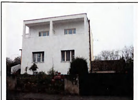
Obr. č. 50 Vila rodiny Zimových v ulici Na Habrové č. 25, dnes Lumièrů č. 25.
