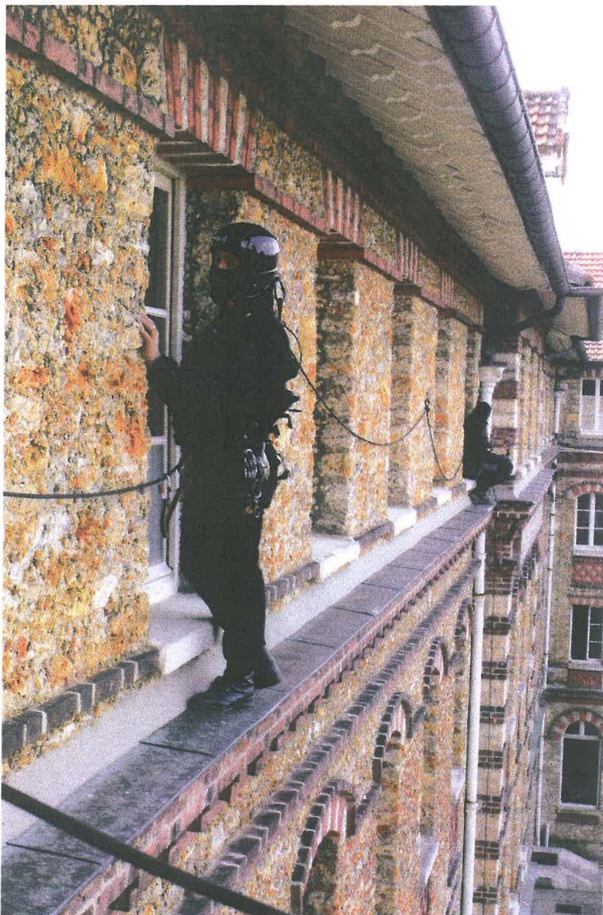
Obr.15, Lanové zábradlí (RAID – Francie, 2006)
