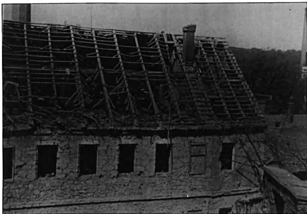
Snímek 10/II. Detail zničené střechy tovární budovy
