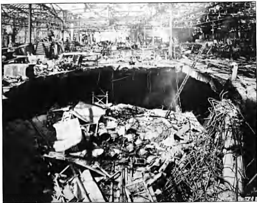
Snímek 11/I. Propadlá podlaha tovární haly
