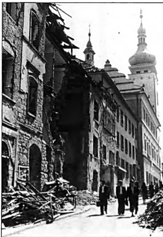
Zasažená Bělská ulice 87
