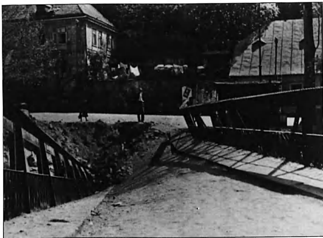
Snímek 10/IV. Detail zničeného mostu přes slepé rameno Jizery
