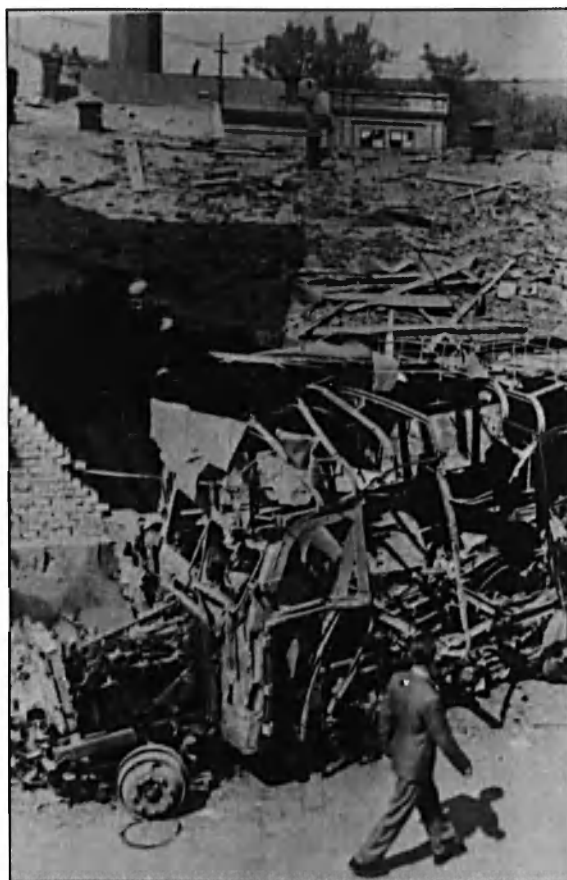
Snímek 10/III. Detail zničeného autobusu, v pozadí patrně zřícení tovární budovy
