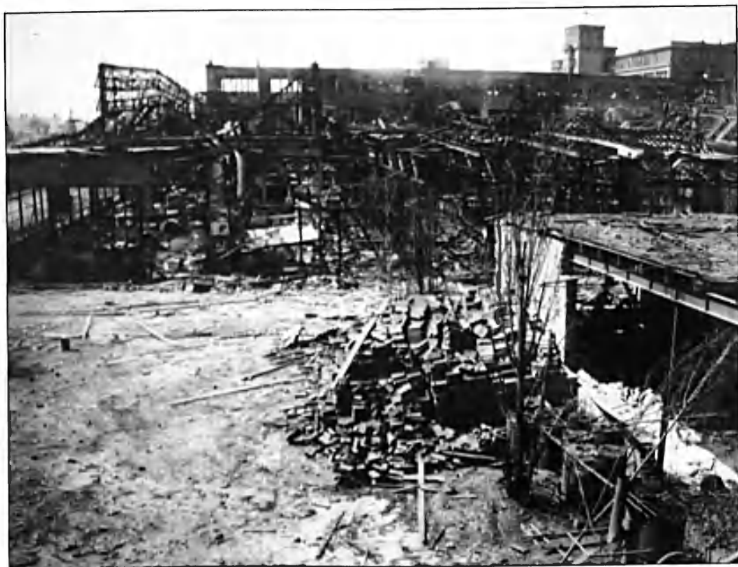
Snímek 11/IV. Pozůstatky po požáru v továrně ASAP
