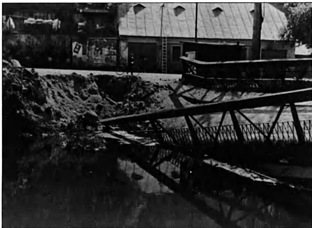
Zničený most přes slepé rameno Jizery 91
