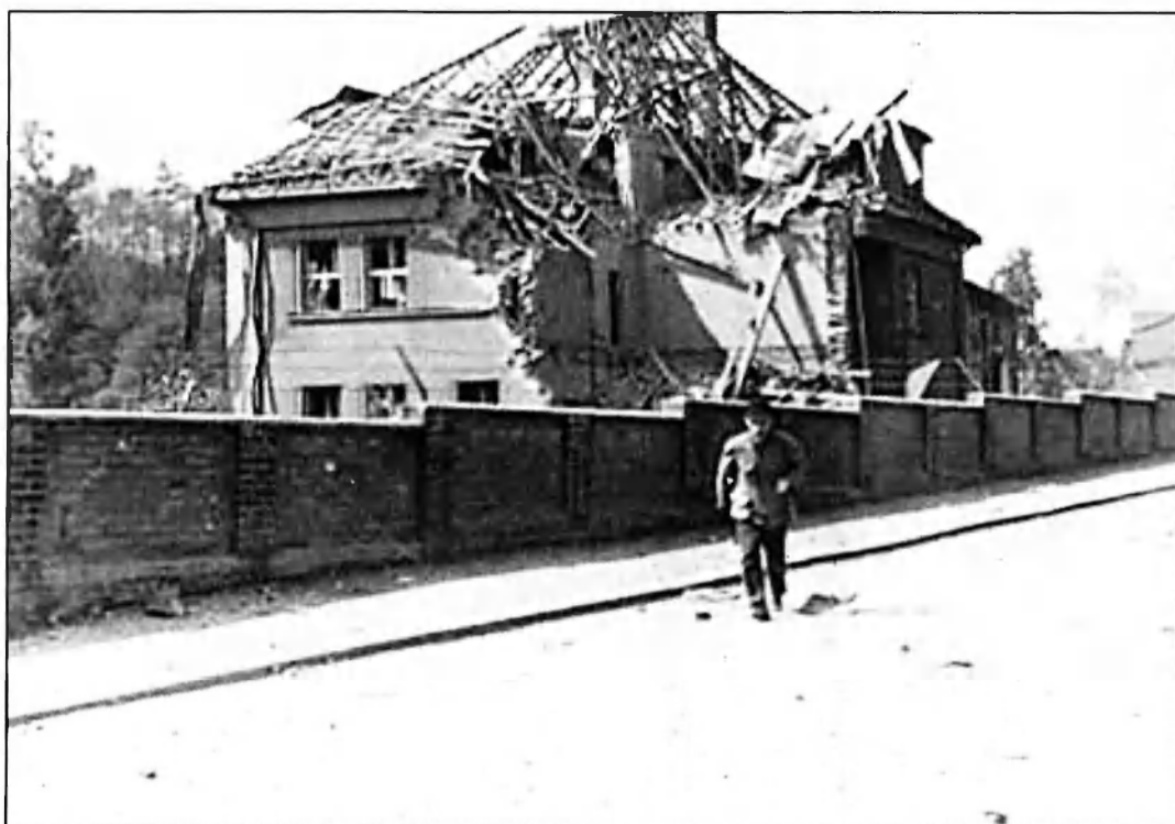
Zničená budova sirotčince ve Střelecké ulici 89
