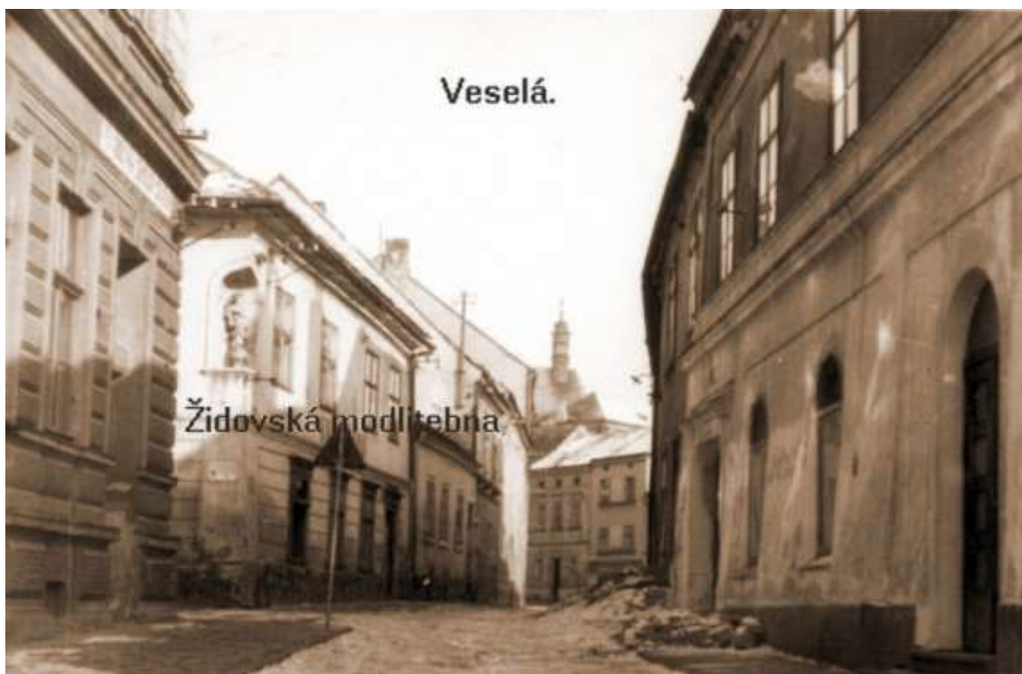
obr. 12 – Pohled na ulici Veselou, dříve židovskou ulici.
