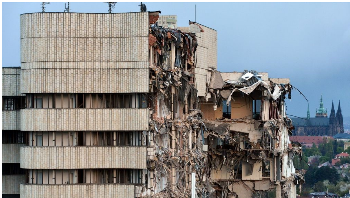
Obr. 13 – pohled na demolici hotelu Praha v roce 2014
