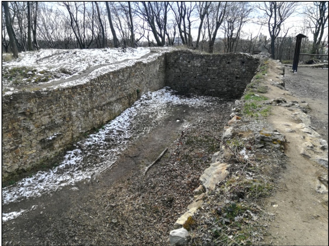
Příloha č. 5: Současný stav suterénu paláce (Fotografie autora).
