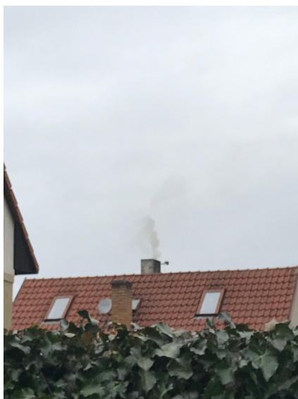
(a) Komín lokálního topeniště K Voškovu 1a
