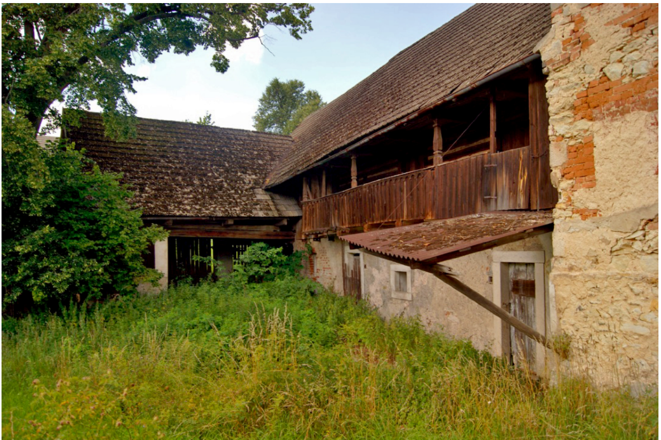
Obr. 7: Hospodářská část klasicistní usedlosti čp. 5 ve Chvalčovicích.
