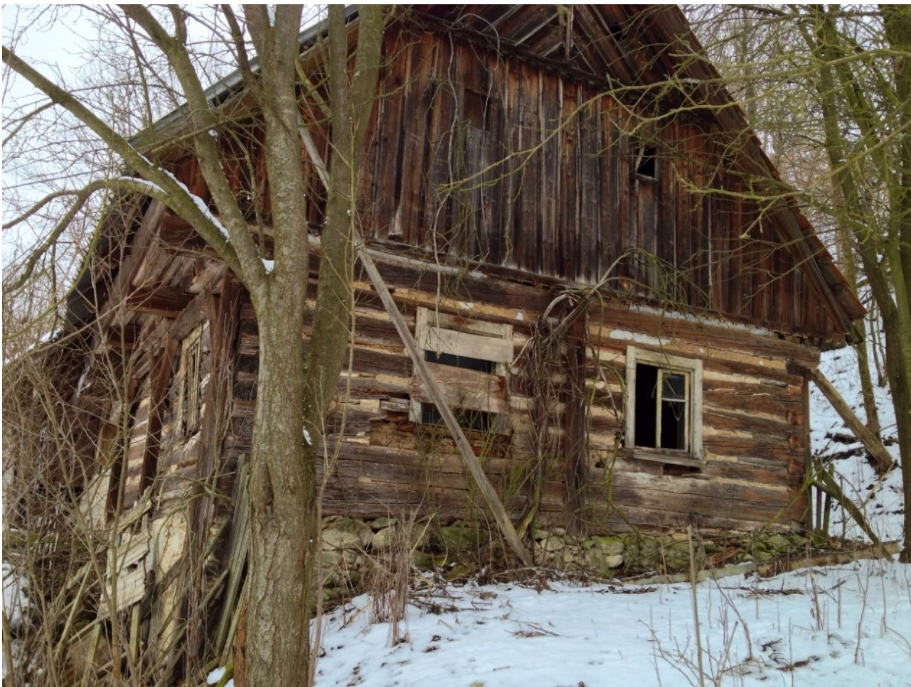
Obr. 44: Zanikající dům čp. 19 v Hradčanech.
