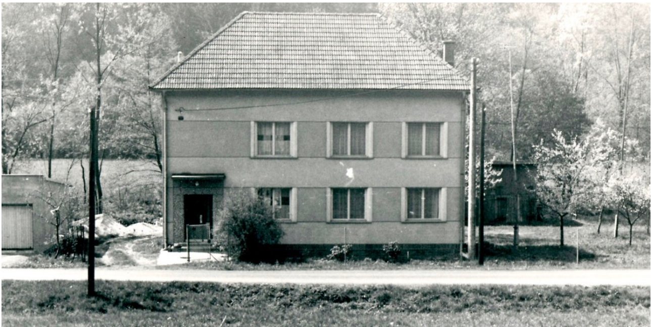
Obr. 63: Dům čp. 23 v Trávníčku.
