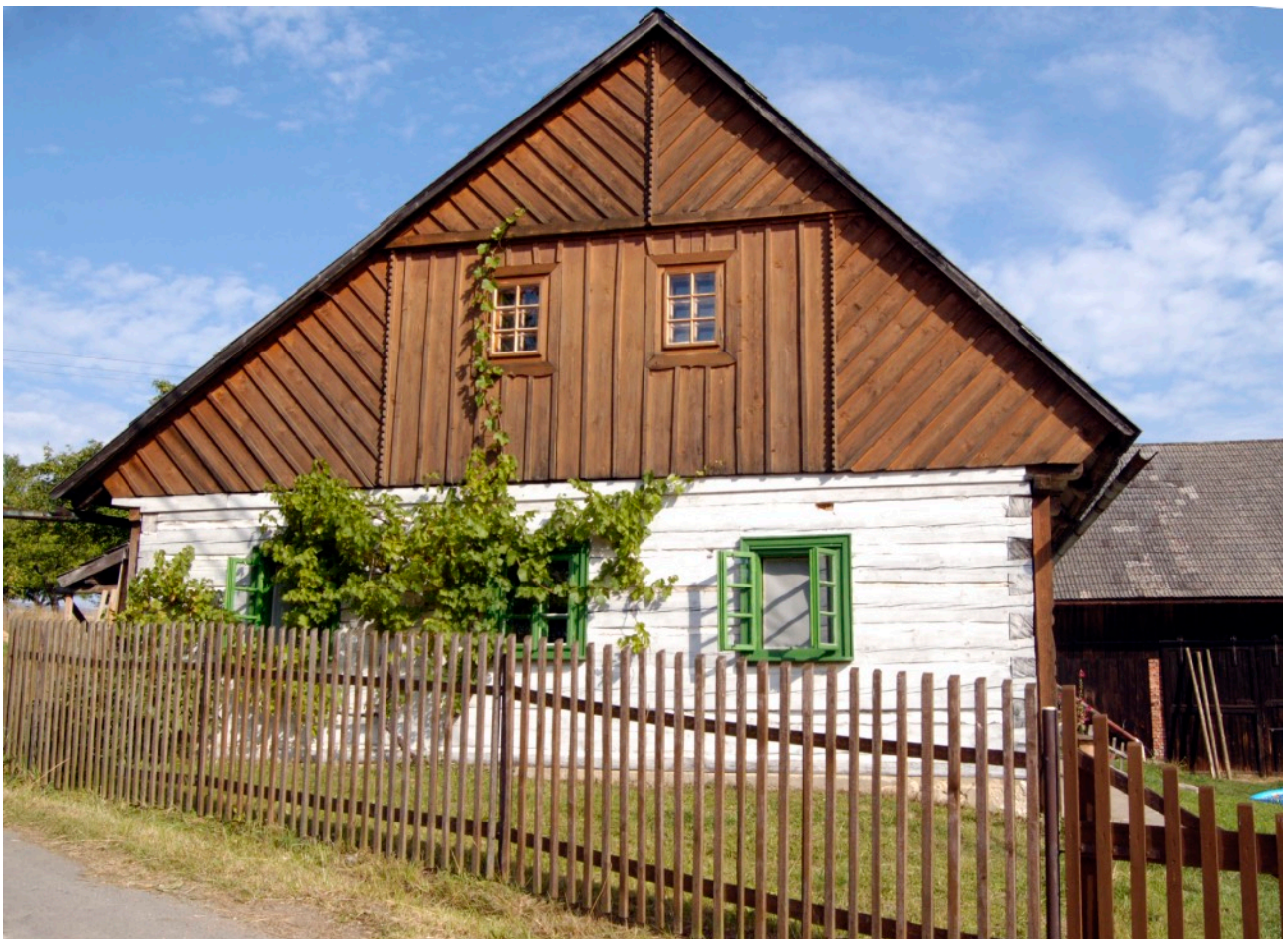
Obr. 43: Dům čp. 28 v Hradčanech po citlivé rekonstrukci
