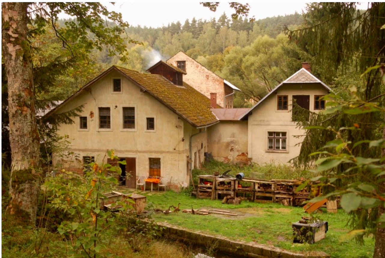
Obr. 77: Bývalý Družstevní mlýn v Trávníčku čp. 32, sídlo MNV a JZD Hradčany.
