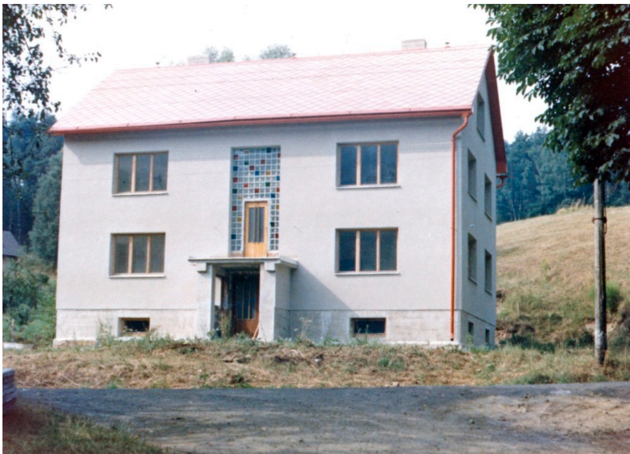
Obr. 37: Bytový dům čp. 30 postavený v roce 1976 v Trávníčku.
