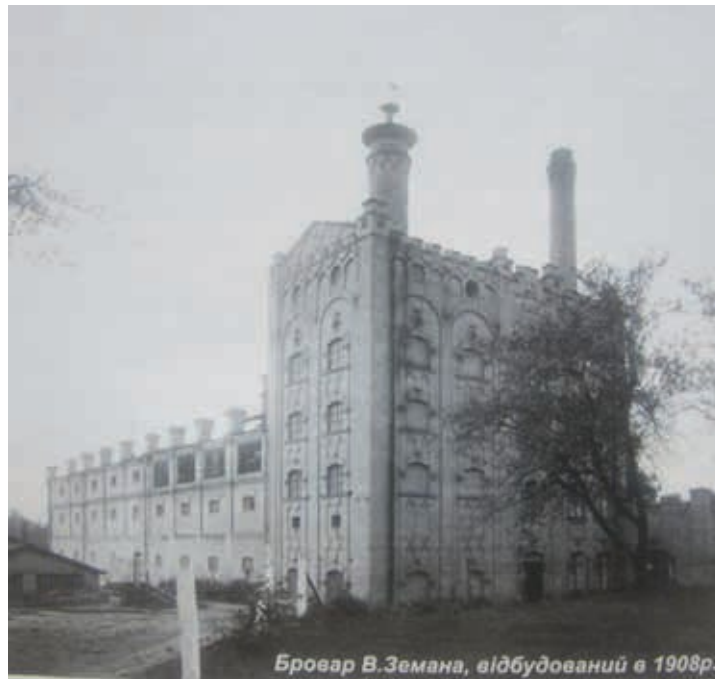
28. Pivovar v Lucku, založený 1877 a rekonstruovaný v roce 1908 (archiv autorky)
