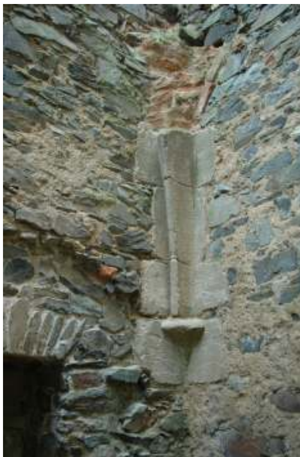
28 c. Hrad Krakovec, \frac{3}{4} 14. století, konzola s výběhem klenebných žeber, severní místnost sklepů západního křídla paláce.
