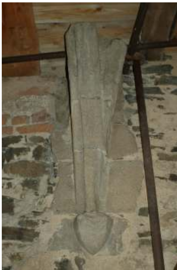
22. Hrad Krakovec, \frac{3}{4} 14. století, konzola s výběhem klenebných žeber, západní stěna kaple.
