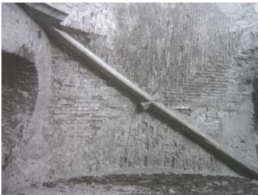
25. Hrad Krakovec, \frac{3}{4} 14. století, severní pole jihozápadního prostoru sklepů.
