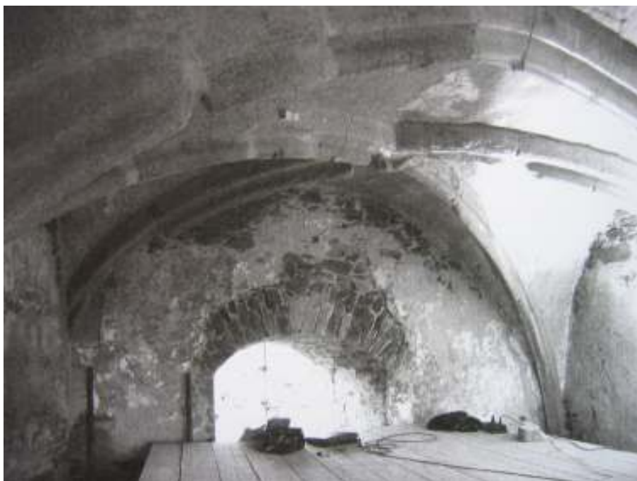
24. Hrad Krakovec, \frac{3}{4} 14. století, severní pole jihovýchodního prostoru pod kaplí.
