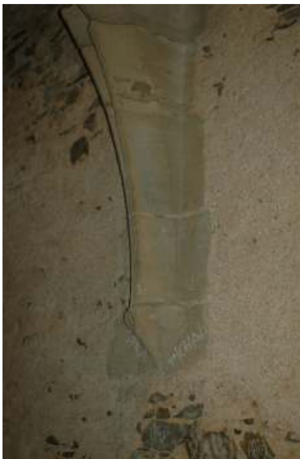
28 m. Hrad Krakovec, \frac{3}{4} 14. století, konzola s výběhem klenebných žeber, jižní místnost sklepů západního křídla paláce.
