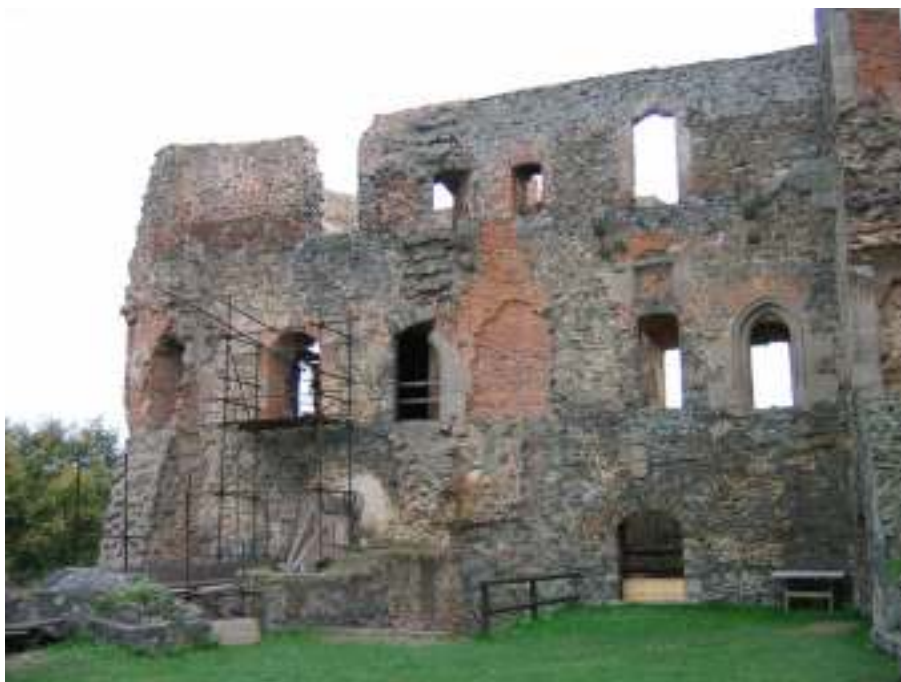
15. Hrad Krakovec, \frac{3}{4} 14. století, nádvoří strana jižního křídla paláce.
