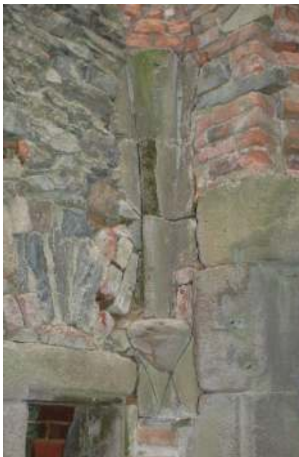
28 k. Hrad Krakovec, \frac{3}{4} 14. století, konzola s výběhem klenebných žeber, prostřední místnost sklepů západního křídla paláce.
