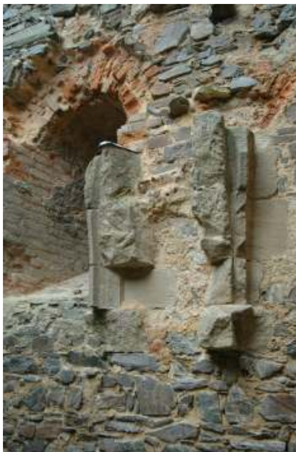
28 b. Hrad Krakovec, \frac{3}{4} 14. století, výběhy klenebných žeber, severní místnost sklepů západního křídla paláce.
