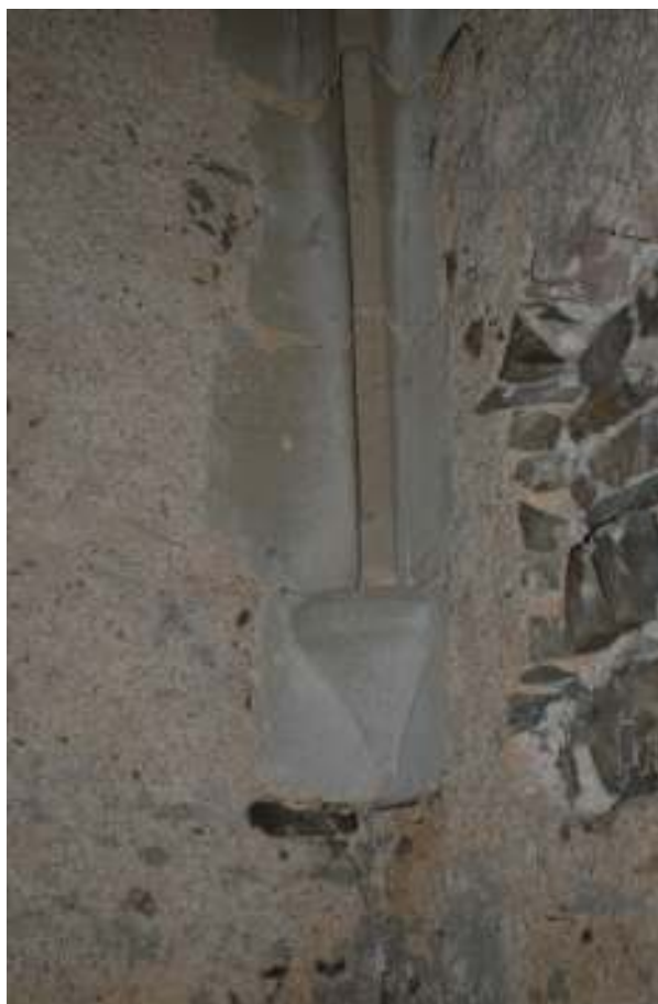
28 l. Hrad Krakovec, ¾ 14. století, konzola s výběhem klenebných žeber, jižní místnost sklepů západního křídla paláce.
