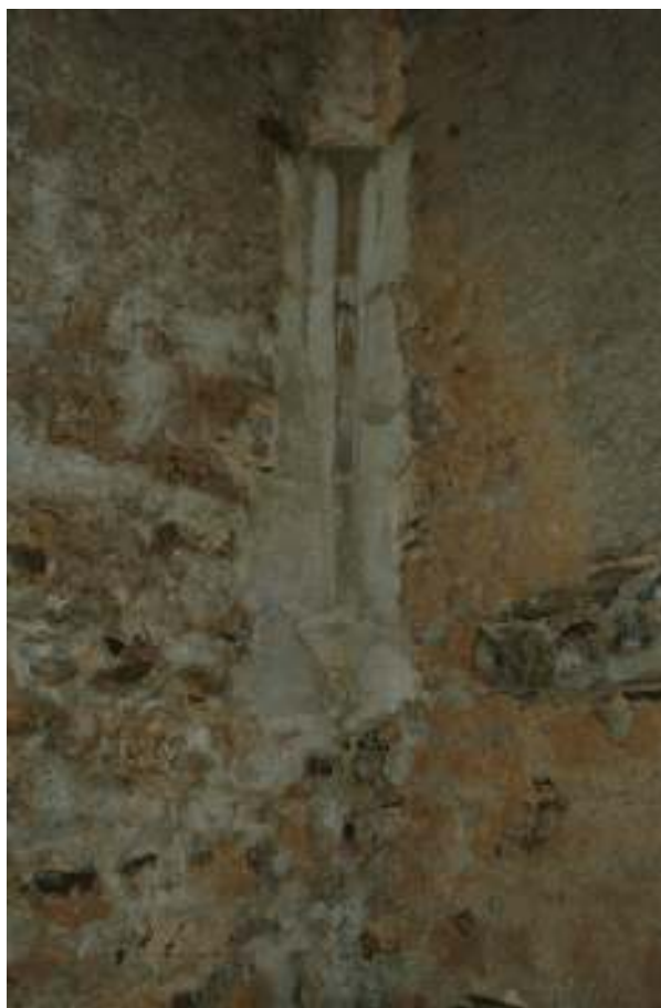
28 o. Hrad Krakovec, \frac{3}{4} 14. století, konzola s výběhem klenebných žeber, jižní místnost sklepů západního křídla paláce.
