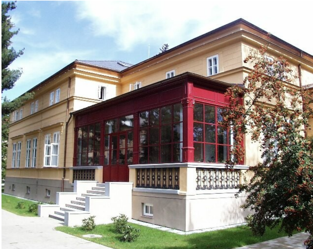
Západní pohled na budovu
