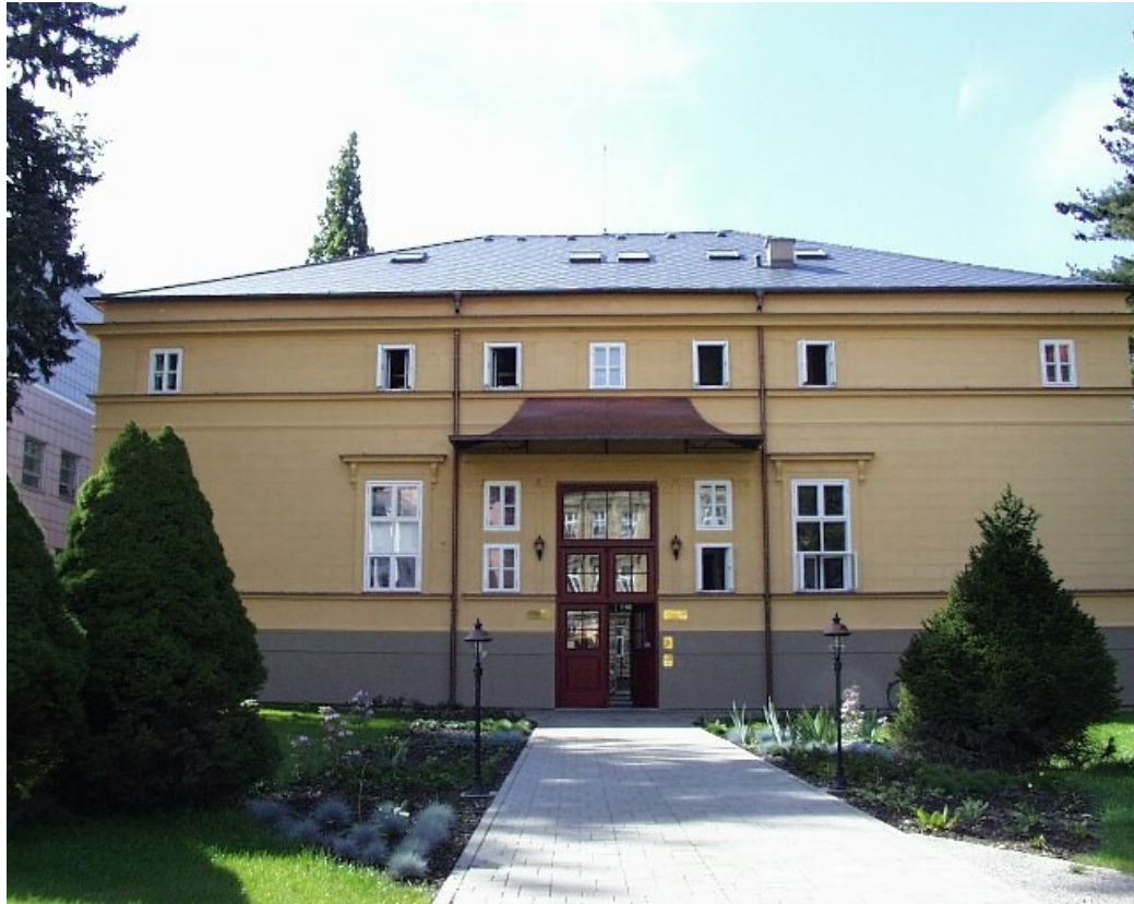
Budova Na Sadech
