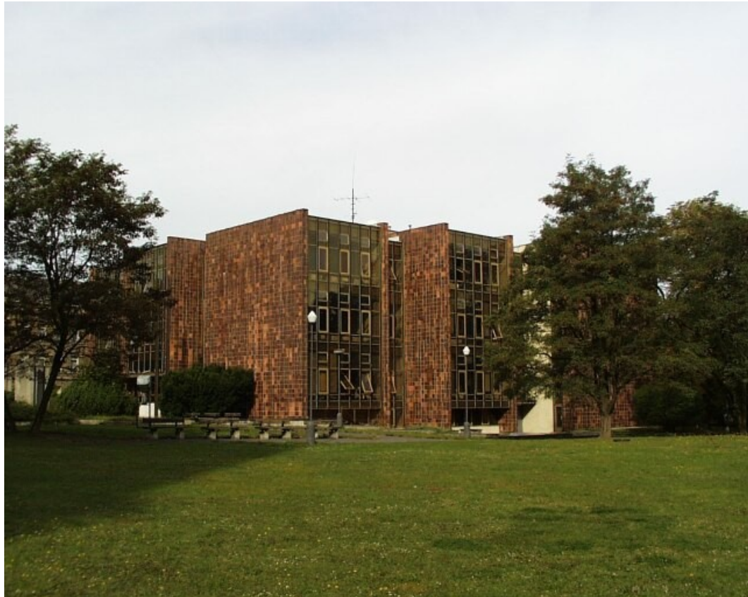
Jihovýchodní pohled na budovu a okolní park
