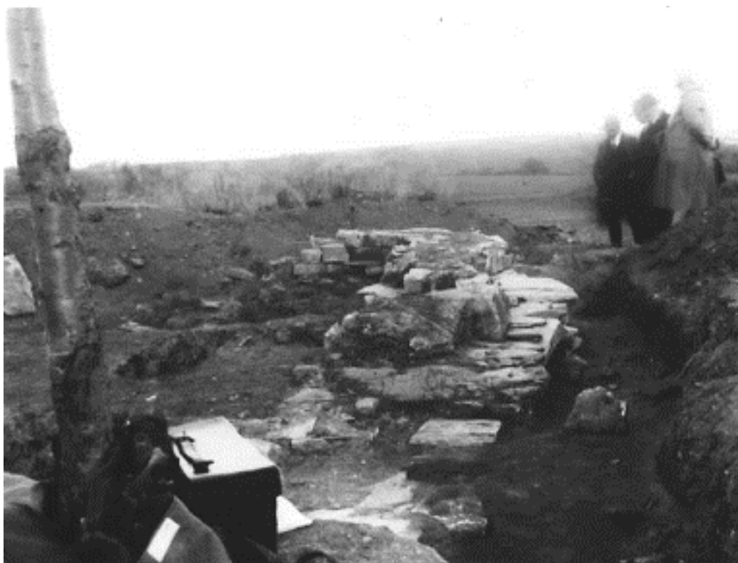
FOTO 8. Jižní zeď kostela P. Marie a část apsidy, pohled od západu; na snímku je patrná odlišná konstrukce a šířka nadzemního a základového zdiva; výzkum J. Böma, r. 1931 (SOMMER 1977, 52, tab XXVIII-1).
