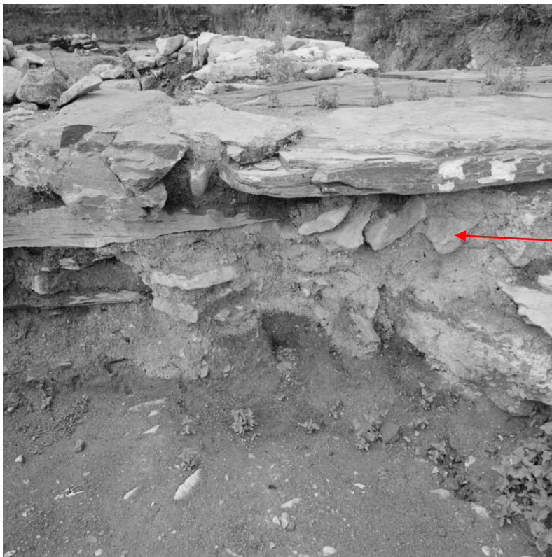
FOTO 9. Základové zdivo západní stěny lodi kostela P. Marie; šipka označuje řadu kamenů, kterou M. Šolle popisoval jako opus spicatum ; výzkum M. Šolleho, r. 1978 (digitální archiv fotografií Archeologického ústavu AV ČR v Praze, ev. č. FT000057724, upraveno).
