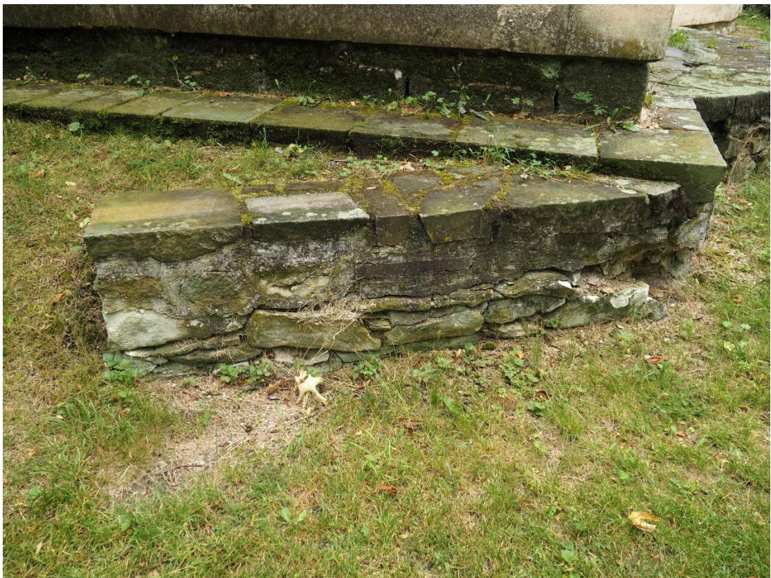
FOTO 63. Situace severně od románské věže rotundy sv. Petra a Pavla na Budči, pohled na maketu zdiva v místě západní brány do hradiště; stav k 17.7.2020 (foto: P. Tomanová).
