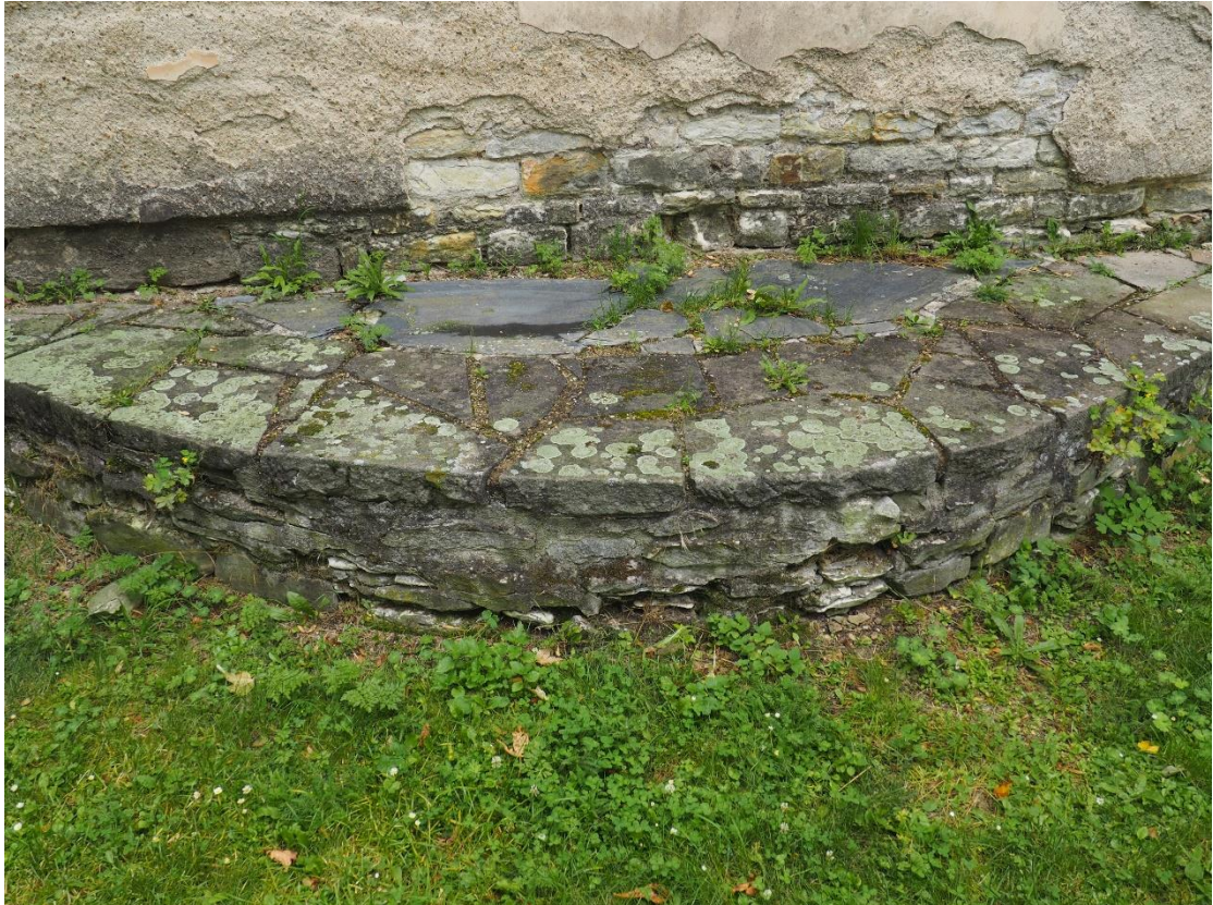
FOTO 62. Situace západně od románské věže rotundy sv. Petra a Pavla na Budči, pohled na maketu zdiva severní apsidy; stav k 17.7.2020 (foto: P. Tomanová).
