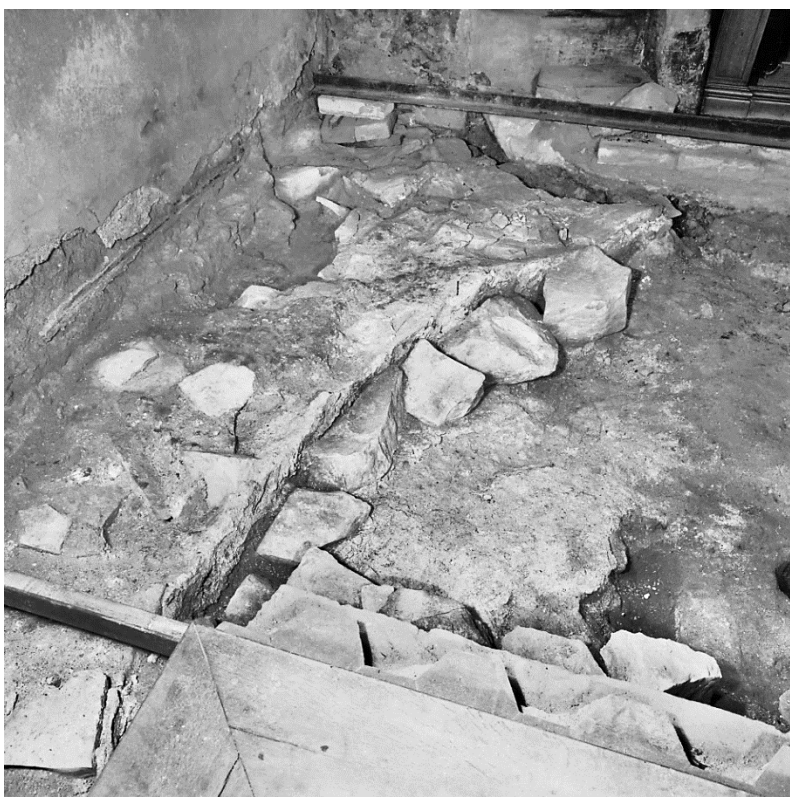
FOTO 47. Sonda v presbytáři rotundy, jižní část presbytáře, pohled od západu na zbytky původní maltové podlahy a pozůstatky zdiva původní východní apsidy, výzkum M. Šolleho, r. 1978 (digitální archiv fotografií Archeologického ústavu AV ČR v Praze, ev. č. FT000057678).
