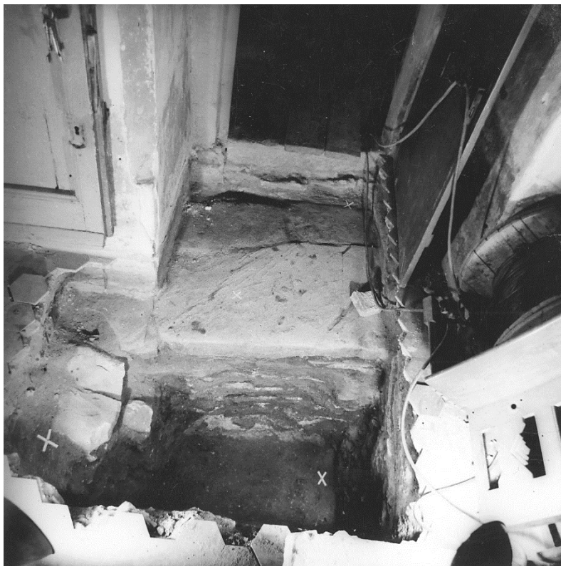
FOTO 58. Sonda v interiéru románské věže, pohled od severu na jižní řez sondou na řezu patrné základy věže; výzkum M. Šolleho, r. 1980 (digitální archiv fotografií Archeologického ústavu AV ČR v Praze, ev. č. FT000058878).
