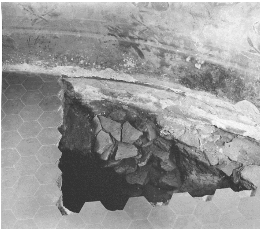
FOTO 33. Sonda v severovýchodní části lodi, pohled od jihu na kamennou destrukci interpretovanou M. Šollem jako základ polopilíře; výzkum M. Šolleho, r. 1979 ( ŠOLLE 1982N , 1, č. neg. 57936).
