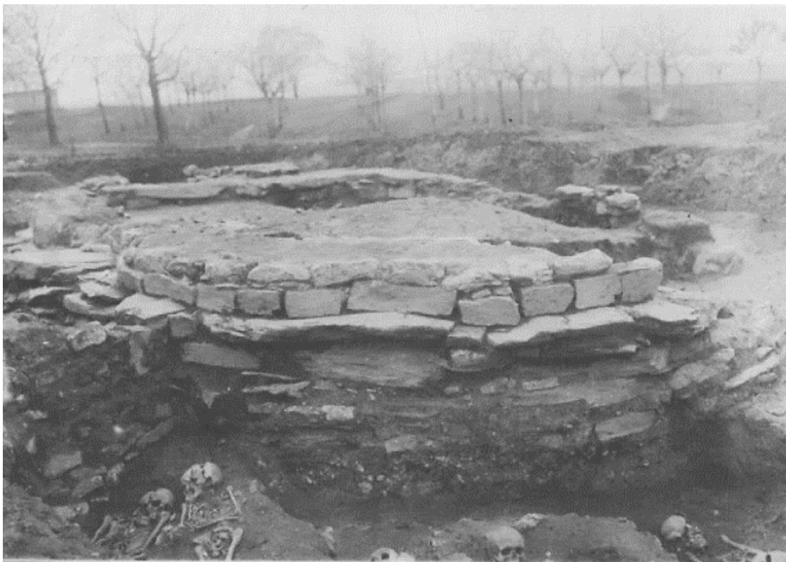
FOTO 1. Pohled na vnější zdivo apsidy kostela P. Marie; snímek zachycuje odlišnou konstrukci a šířku nadzemního a základového zdiva; výzkum J. Böhma, r. 1931 ( SOMMER 1977 , 54, tab. XXX-1).
