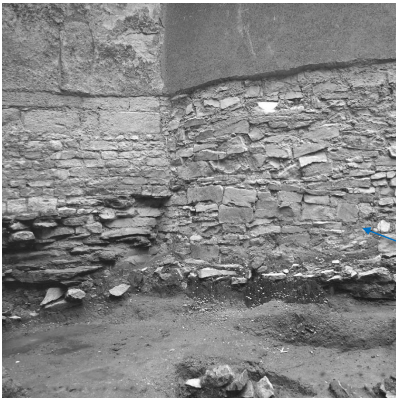
FOTO 21. Rotunda sv. Petra a Pavla na Budči, odhalené románské zdivo věže a lomové zdivo rotundy, pohled od severozápadu; šipka ukazuje na odlišný úsek zdiva rotundy z velkých kvádrů; výzkum M. Šolleho, r. 1978 (digitální archiv fotografií Archeologického ústavu AV ČR v Praze, ev. č. FT000057727, upraveno).
