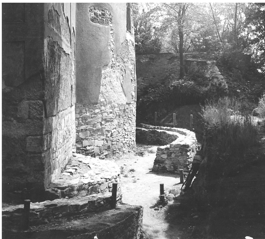
FOTO 59. Situace západně od rotundy sv. Petra a Pavla, rekonstrukce zadní plenty hradby obíhající rotundu a dozděný segment severní apsidy při západní stěně románské věže; výzkum M. Šolleho, r. 1980 (digitální archiv fotografií Archeologického ústavu AV ČR v Praze, ev. č. FT000058834).
