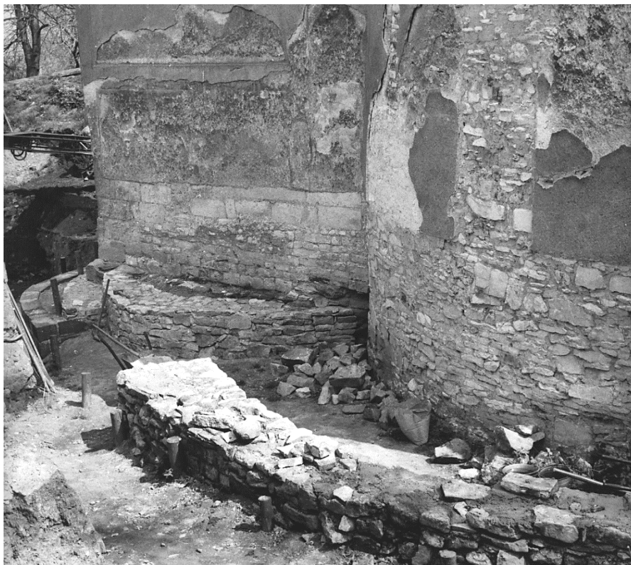
FOTO 60. Situace západně od rotundy sv. Petra a Pavla, obnažené zdivo lodi rotundy a věže, v popředí rekonstruovaná zadní plenta hradby, u věže dozděně zdivo severní apsidy; výzkum M. Šolleho, r. 1980 (digitální archiv fotografií Archeologického ústavu AV ČR v Praze, ev. č. FT000058838).
