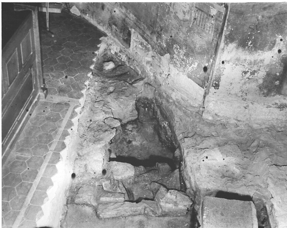
FOTO 26. Interiér rotundy sv. Petra a Pavla, severovýchodní část lodi u vítězného oblouku, v sondě odkryté pozůstatky výběžků zdiva (?); výzkum M. Šolleho, r. 1979 (ŠOLLE 1982N, 2, č. neg. 57939).
