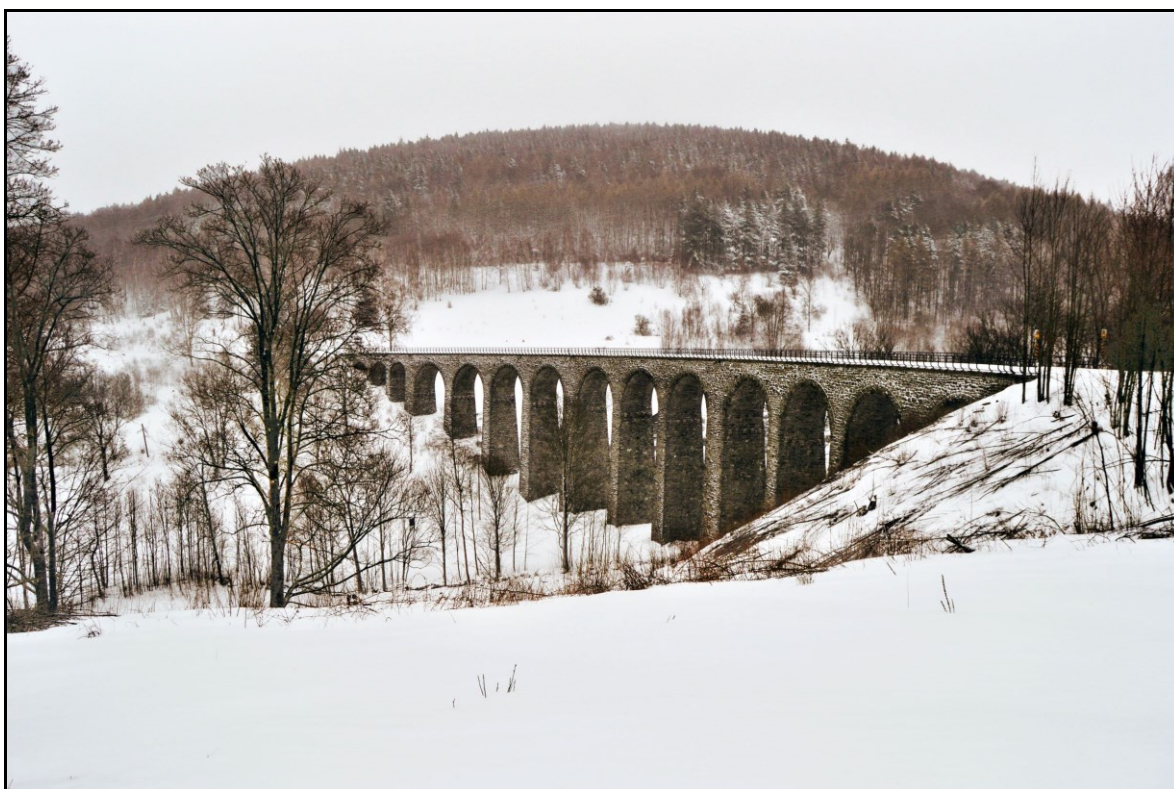
Obrázek 16: Novinský viadukt v zimě
