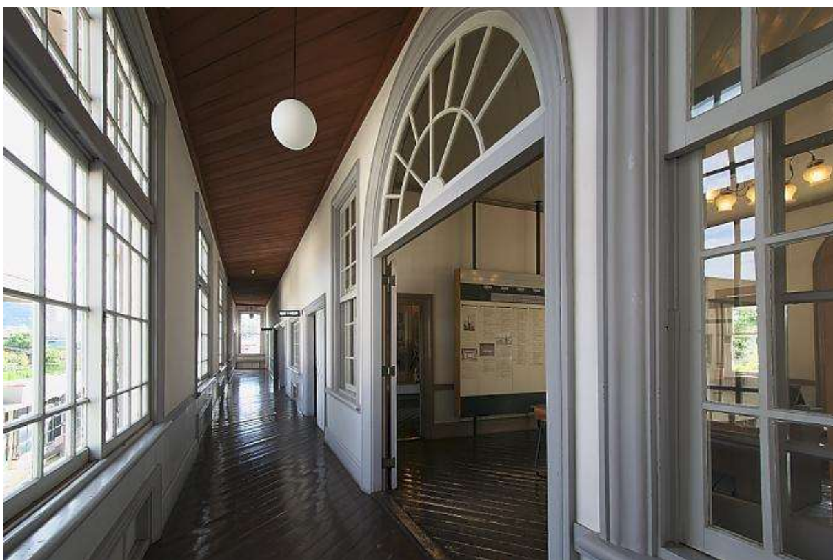
Obr. 33 V interiéru Pedagogické školy v Jamagatě najdeme neobyklou, uhlopříčně položenou dřevěnou podlahu a zrcadlově obrácené uhlopříčné obkládání na stropě.
