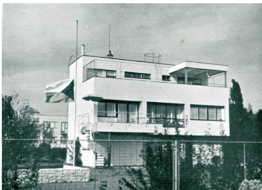
182. Kamil Ossendorf – R. F. Podzemný, Rodinný dům JUDr. Františka Švece Českých Budějovicích, 1933 Kamil Ossendorf – R. F. Podzemný, Rodinný dům dr. F. Š. v Českých Budějovicích, Stavitel XVI , 1937–1938, s. 60–61, s. 60
