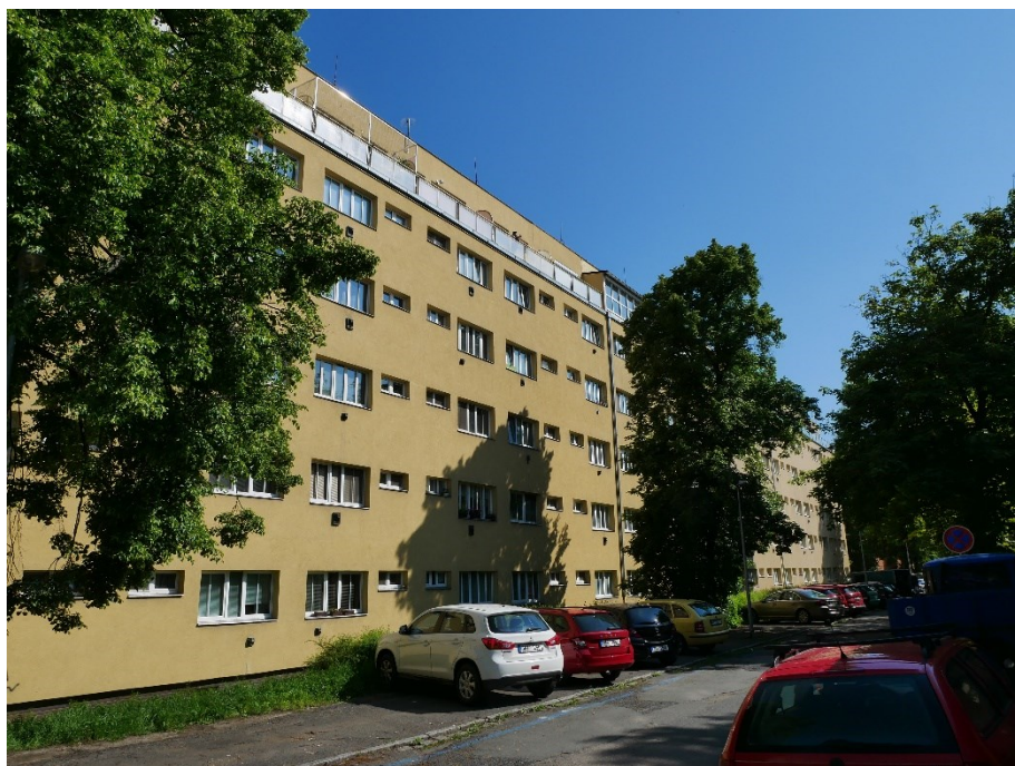
269. František Míšek, Domy s malými byty obce pražské, Praha-Libeň, 1938–1939, pohled od jihu (foto: autorka, 2021)
