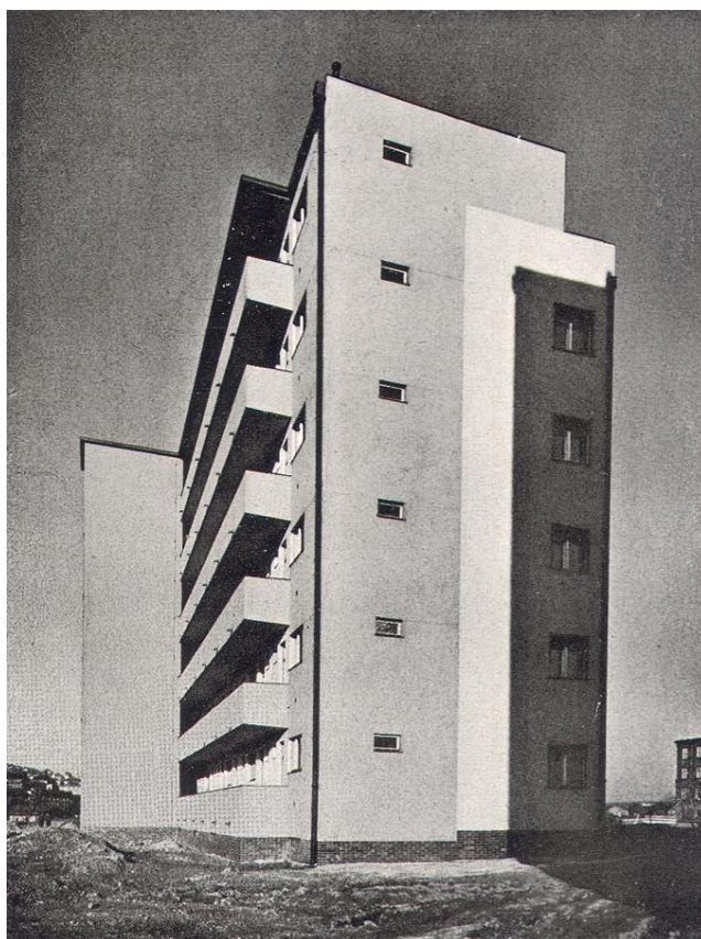
261. Josef Chochol – R. F. Podzemný, Domy s malými byty obce pražské, Praha-Libeň, 1938–1939, pohled od západu J. Chochol – R. F. Podzemný, Domy pro chudé obce pražské v Libni, Architektura, spojené časopisy Stavba, Stavitel, Styl II , 1940, s. 203–204, s. 199 (foto: F. Illek – A. Paul)
