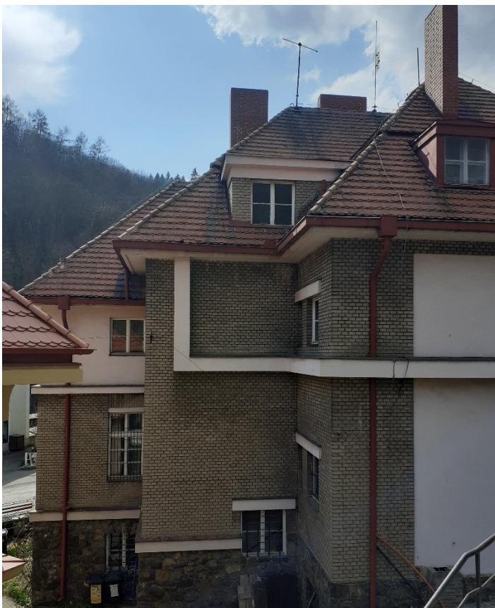
91. Jaroslav Rössler: Hospodářská záložna, Křivoklát, detail fasády, 1925-1926
