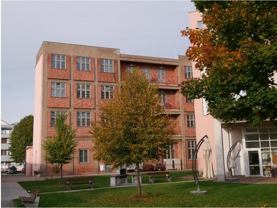
108. Otakar Novotný: Otakar Novotný: Stravovna a noclehárna – Sehnoutkův dům, Černožice nad Labem, část jižní fasády, 1926-1927, novodobá přístavba.
