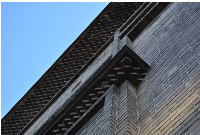
56. Otakar Novotný: Dům F. Sequense, Praha-Vyšehrad, detaily skladby cihel, 1912-1913
