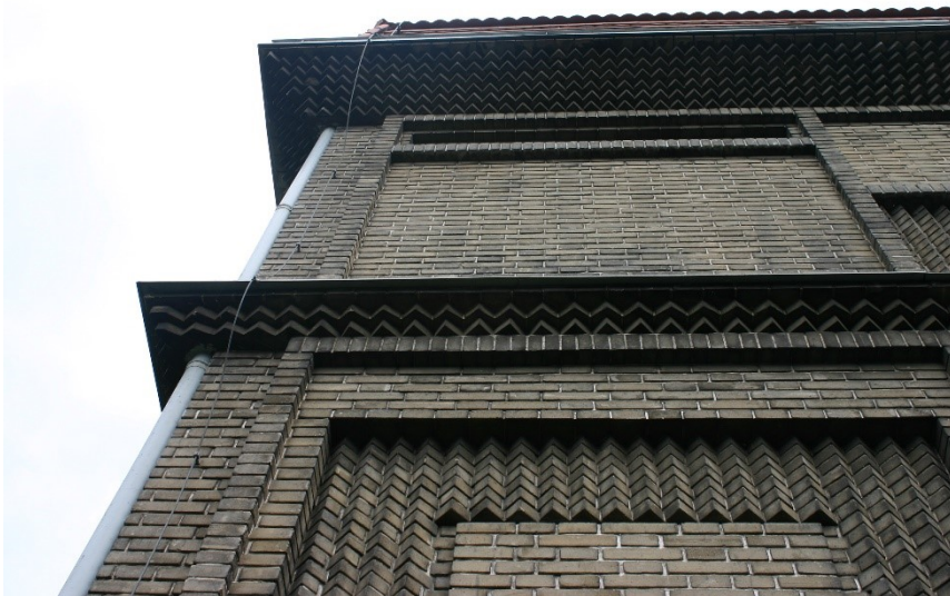
54. Otakar Novotný: Dům F. Sequense, Praha-Vyšehrad, detaily skladby cihel, 1912-1913
