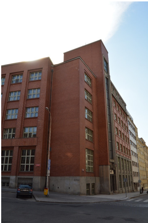
95. Josef Gočár: Dům zemědělské osvěty, Praha-Vinohrady, pohled na schodišťovou věž, 1924-1926
