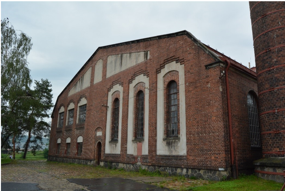
13. William Henry Lindley: Hlavní budova čističky odpadních vod, detail fasády, Praha-Bubeneč, 1900-1906
