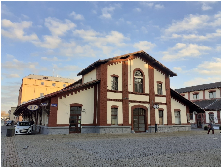
11. Josef Srdínko: Dobytčí jatky a trh, Praha-Holešovice, dokončeno r. 1895
