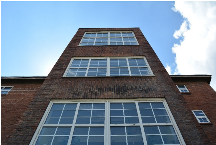
115. Otakar Novotný: Státní vystěhovačká stanice, Praha-Vysočany, detail fasády, 1928-1930
