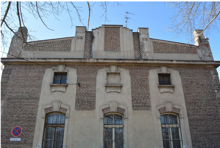
9. Josef Kovařovič: Budova ledáren, Praha-Braník, 1911-1913, detail fasády.
