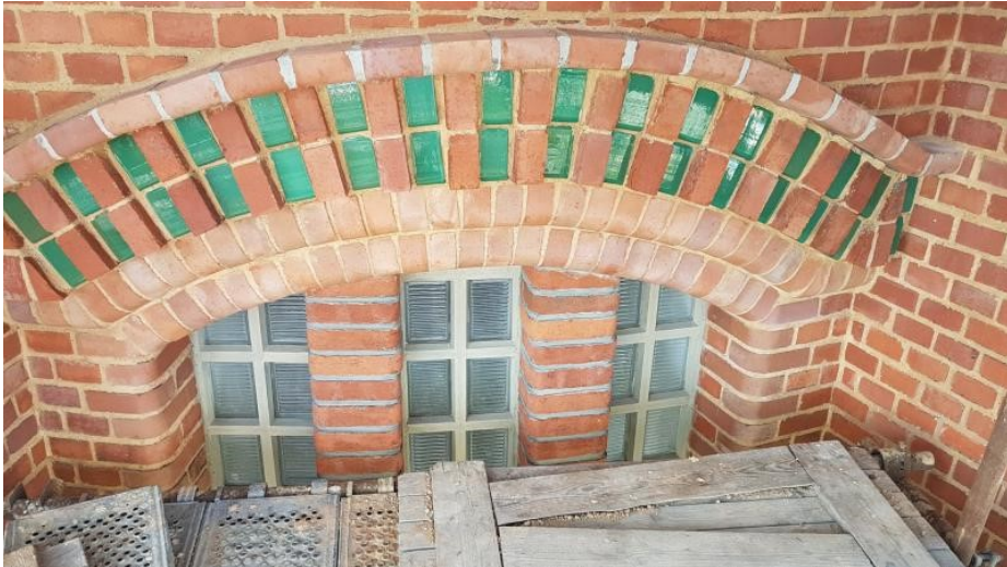
16. Jan Kotěra: Vodárna Města Vršovice, Praha-Michle, detail fasády s glazovanými lícovkami, 1906-1907
