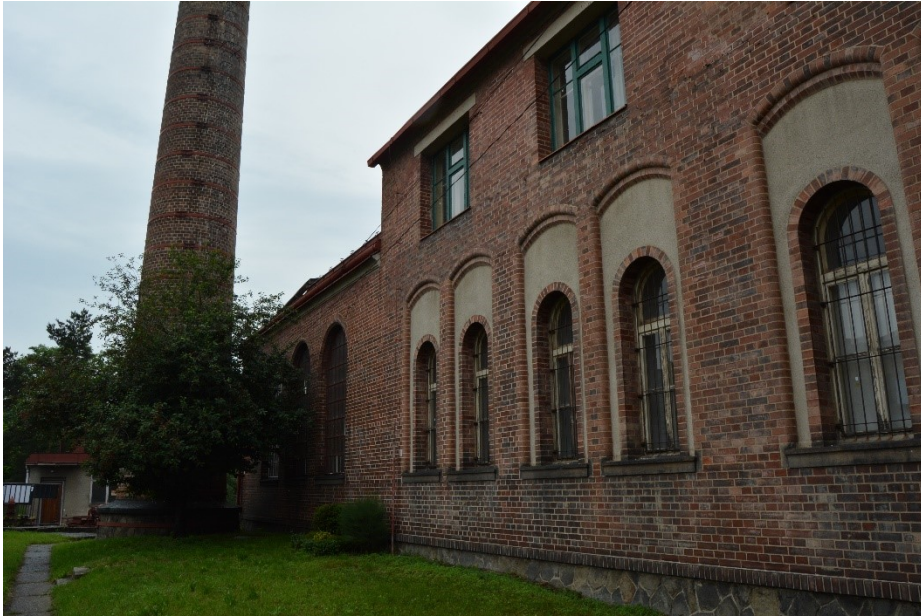
12. William Henry Lindley: Hlavní budova čističky odpadních vod, detail fasády, Praha-Bubeneč, 1900-1906
