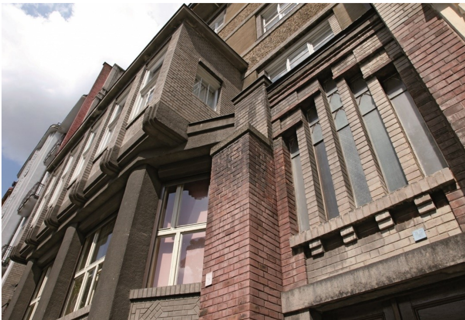
26. Jan Kotěra: Dům J. Laichtera, Praha-Vinohrady, detail fasády, 1908-1909
