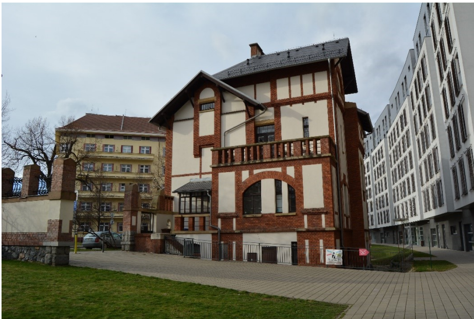
7. František Sander: Přístavní budova, Praha-Holešovice, 1906-1909
