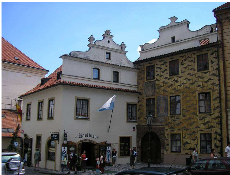
Obrázek 3: Hradčanská radnice, čp. 173, Praha, Hradčany.
