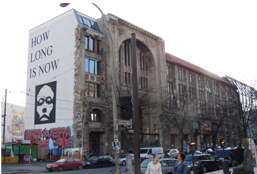
Popis fotografie: Vstup do Tacheles. Pohled na celou budovu z ulice Oranienburgerstrasse. Motiv na stěně budovy je často obměňován.
