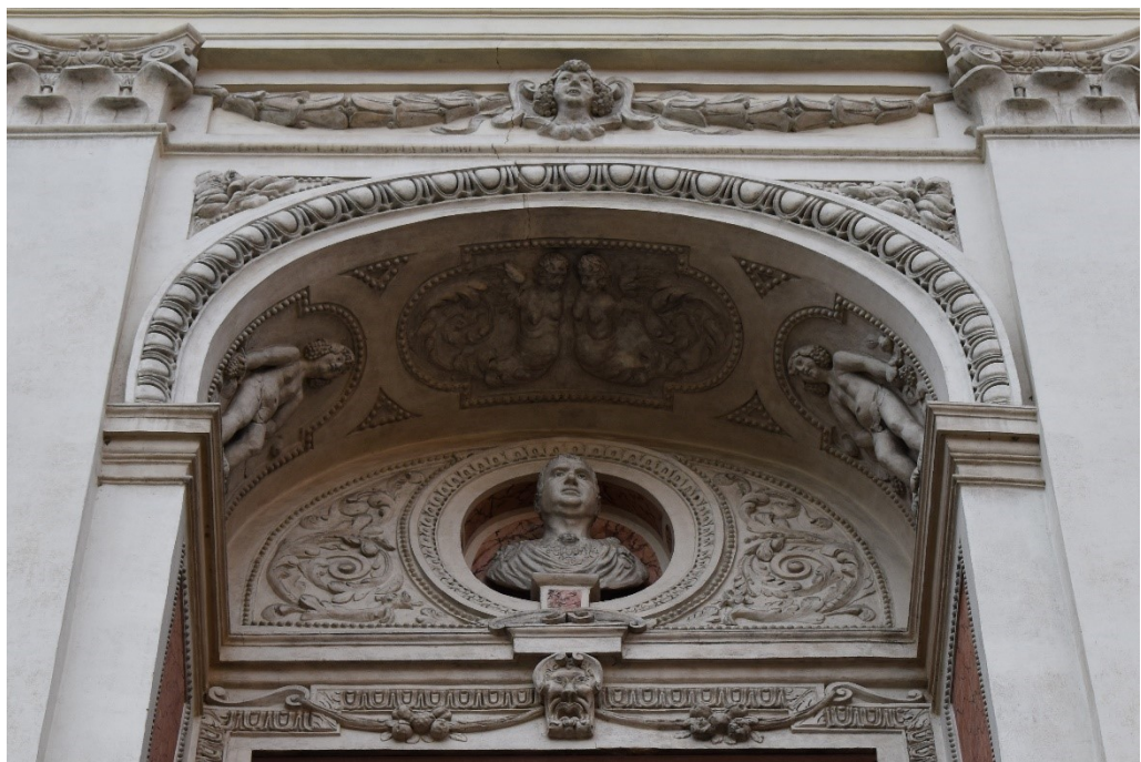
[98] Praha, Malá Strana, Michnův palác, východní průčelí, detail.
