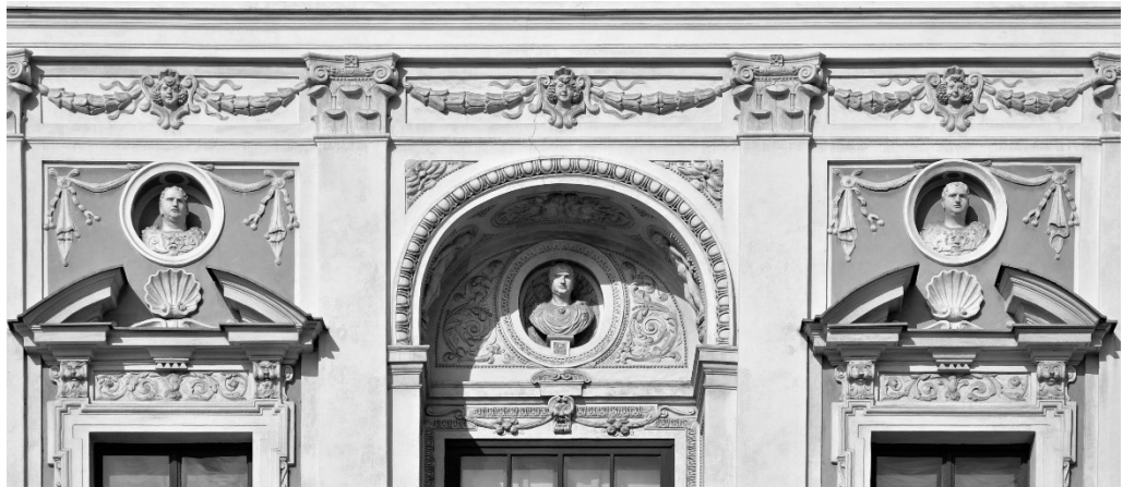
[97] Praha, Malá Strana, Michnův palác, východní průčelí, detail.
