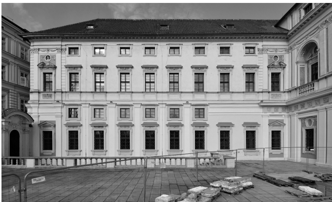
[39] Praha, Malá Strana, Michnův palác, východní průčelí, boční křídlo
