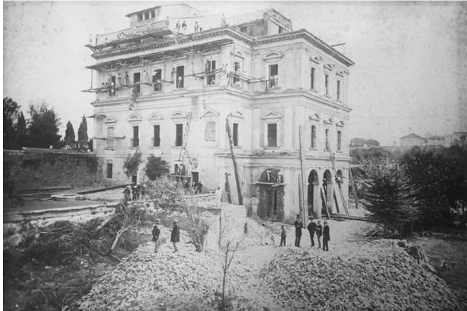
[72] Gioacchino Altobelli, demolice casina Villy Peretti-Montalto, 1868
