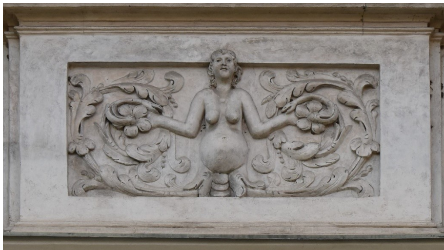
[99] Praha, Malá Strana, Michnův palác, východní průčelí, detail.
