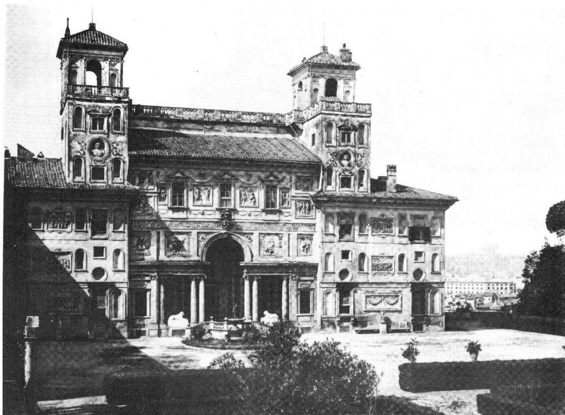
[56] Řím, zahradní průčelí casina Villy Medici, Bartolomeo Ammannati, od 1576
