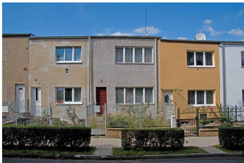
Obr. 10 Josef Hausenblas, Kolonie dělnických domků „Jerusalem“ v ulici Čeňka Zemana čp. 1435–1448 a 1471–1479, Louny, 1931–1932, uliční průčelí, současný stav
