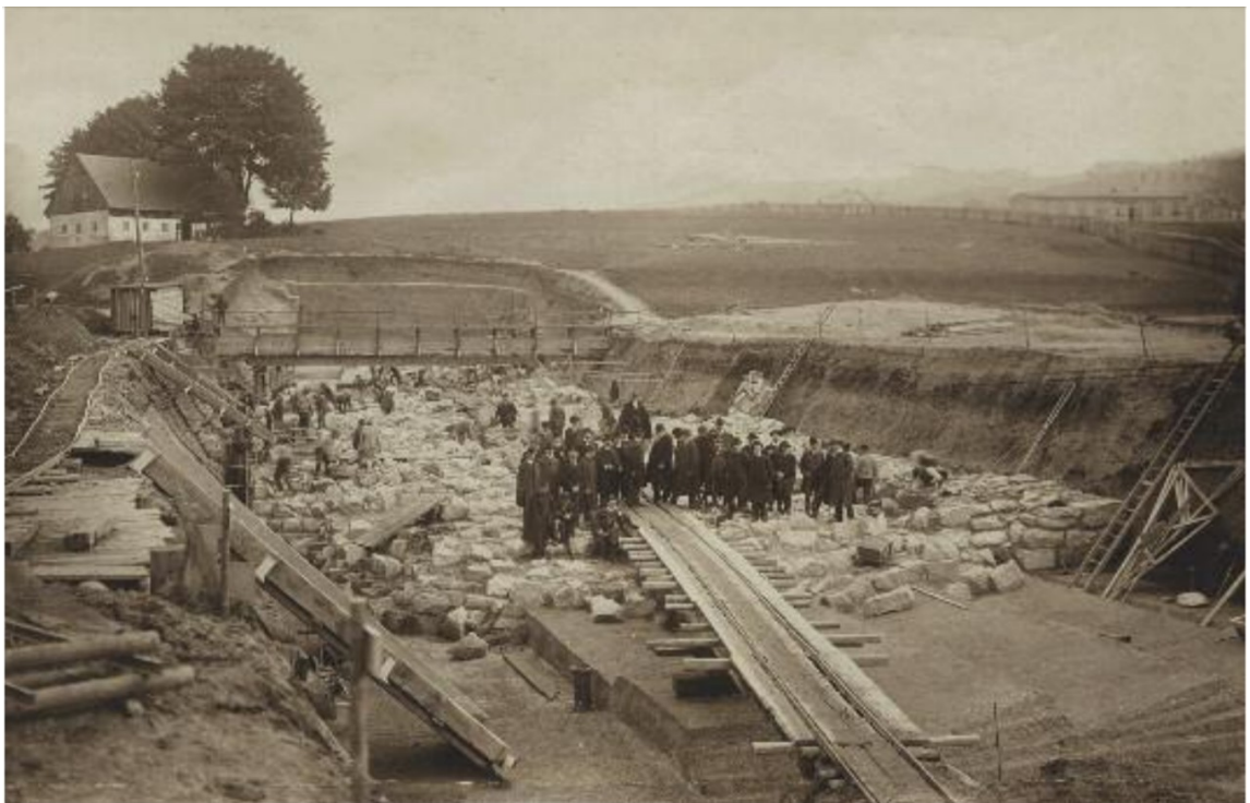
Obr. Č. 17.: Historická fotografie z výstavby Mšenské základové spáry.
