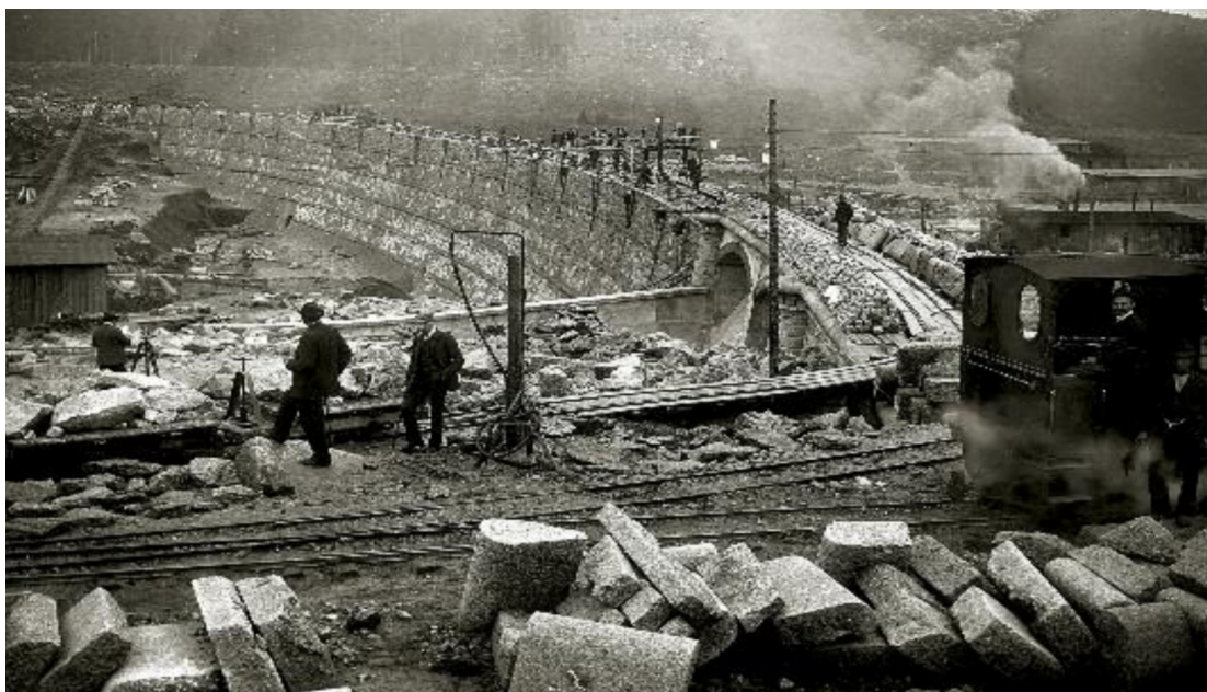
Obr. Č. 8.: Historická fotografie z výstavby Bedřichovské hráze.
