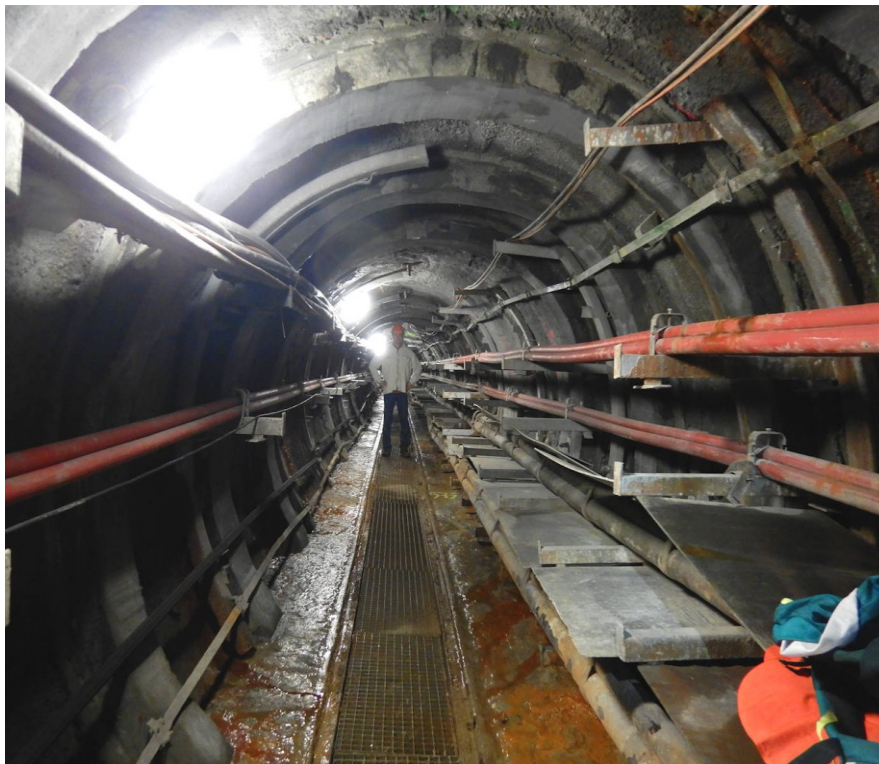
Obr. 3. Detail KT Holešovice, po sanaci, úpravách pažení (nová žebra jsou vidět na stěnách tunelu) a odstranění usazenin ze stěn a stropu KT, foto V. Goliáš, 28. 1. 2020.
