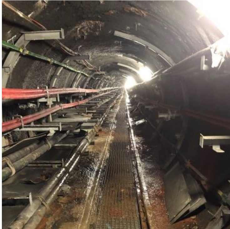
Obr. 2. Detail KT Holešovice, probíhající úpravy pažení a kabelových lávek před sanací (na stropě tunelu jsou patrné vysrážené minerály v podobě krápníků), foto J. Müller, 31. 5. 2019.
