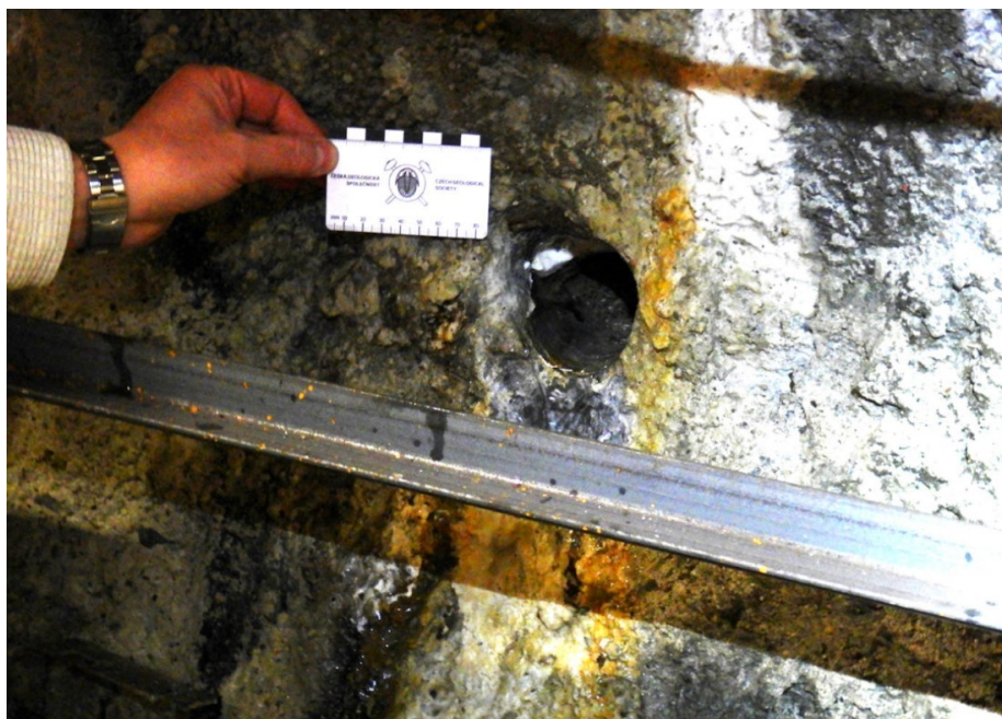
Obr. 10. Detail odlehčovacího vrtu s vytékajícím vývěrem na metrži 54,5 m v KT Holešovice po sanaci, foto V. Goliáš 28. 1. 2020
