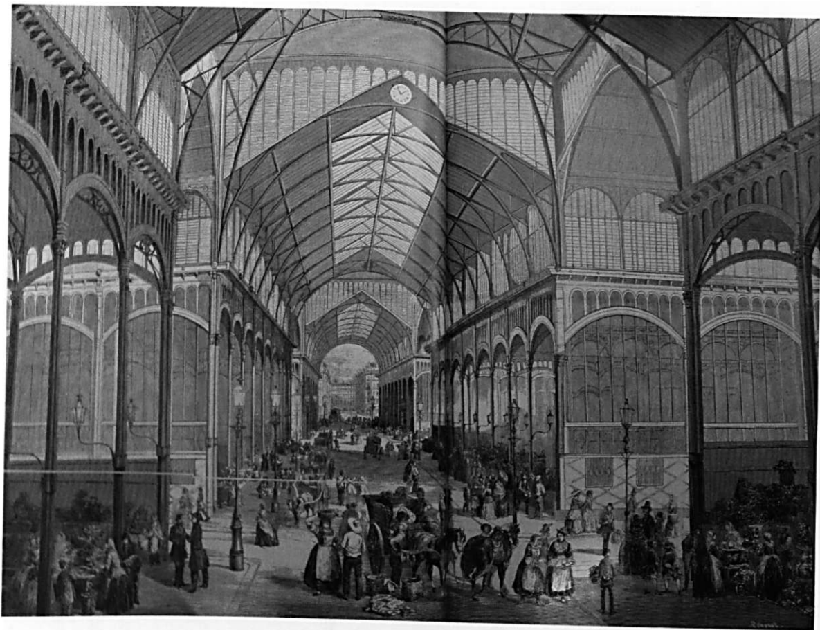
Les Halles, interiér
