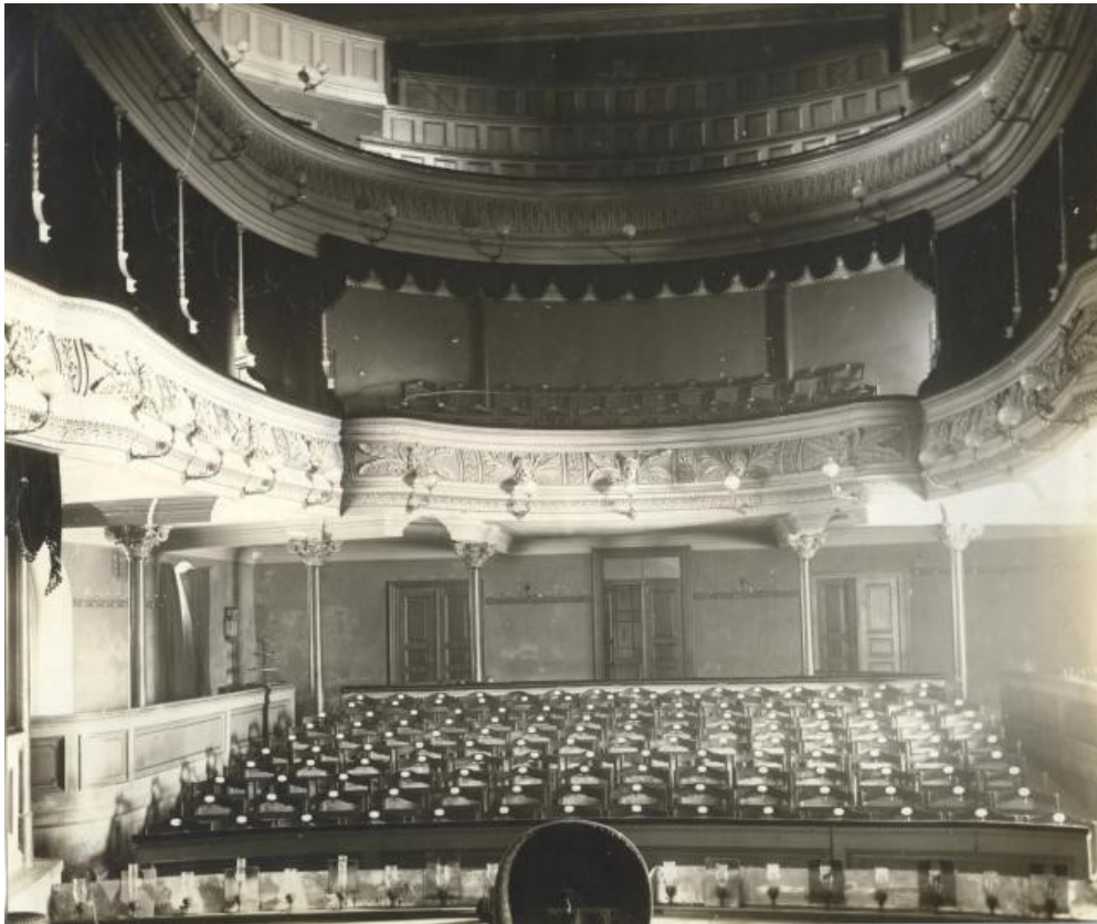
5) Interiér malého sálu před přestavbou roku 1937
