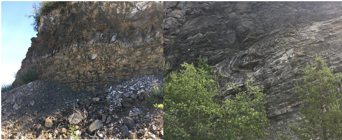
Obrázek 25 Bílé sádrovcové povlaky zvětralých břidlic a frontální pohled na deformační vráso (foto autor)
