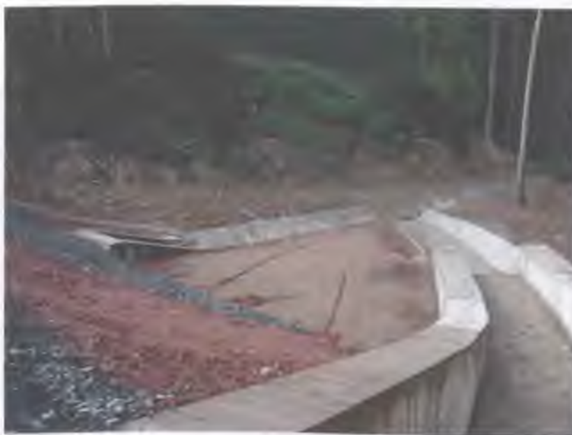
Obr. 2 Nový rybník, pohled na betonovou výpusť za hrází, 2002
