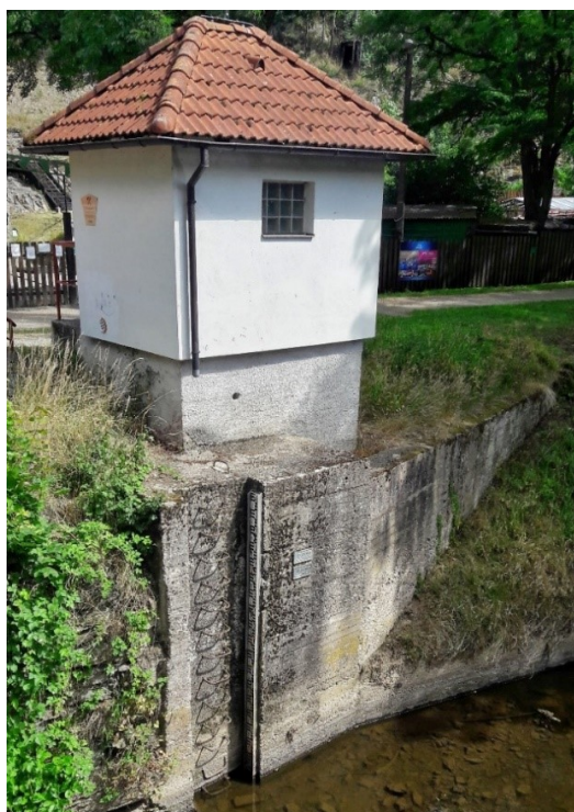
Obr. 12: Vodoměrná stanice Stříbro na řece Mži; pořízeno 5. července 2019 při Q_d = 0,467 \text{ m}^3 \cdot \text{s}^{-1} (zdroj: vlastní fotografie)
