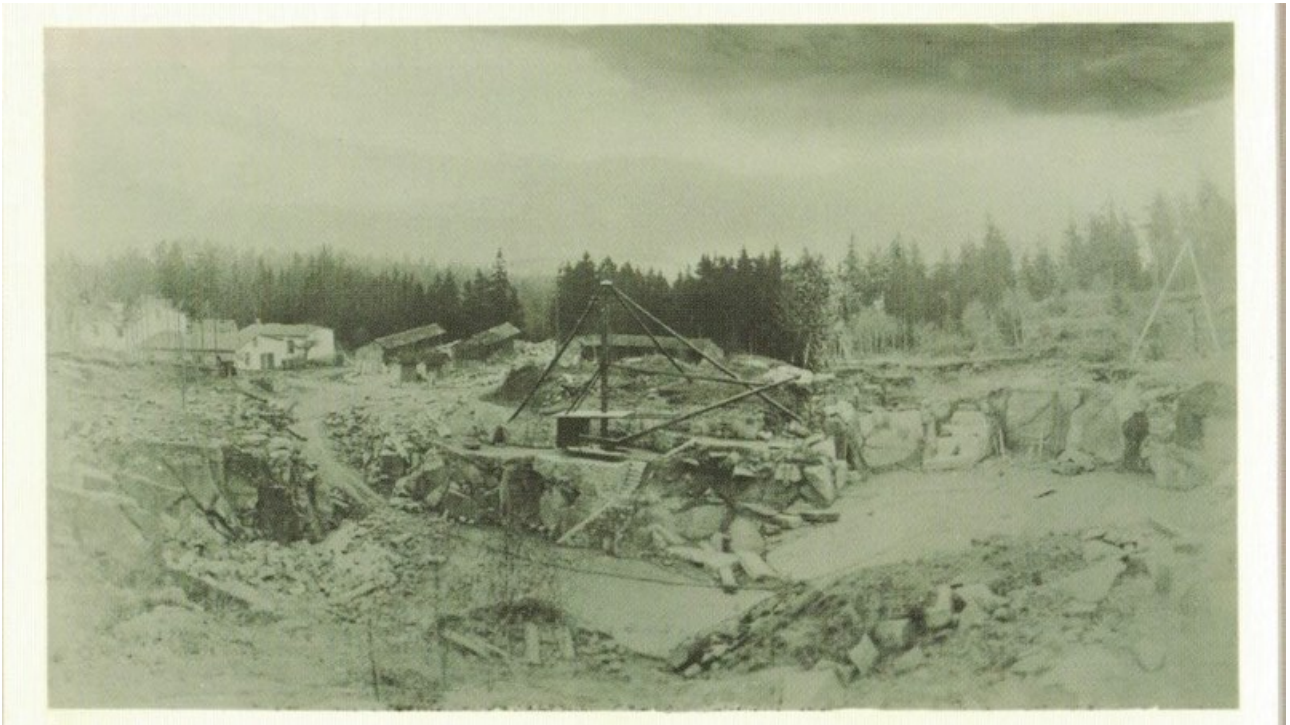
Obr. 13: Historická fotografie lomu Pětka, Lipnice nad Sázavou na starých pohlednicích, 2012
