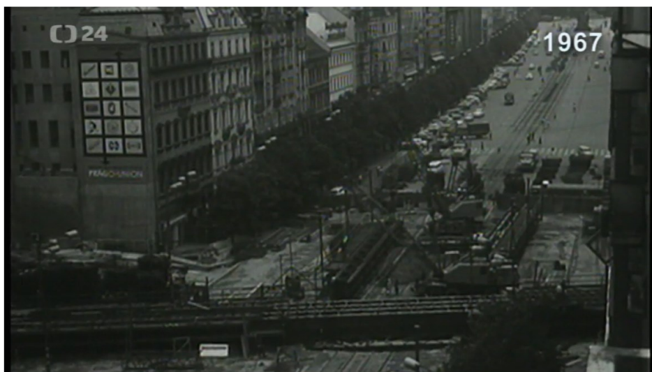
Obrázok 15: Výstavba podchodu na Václavskom námestí – premostenie električkovej trate (1967) 126
