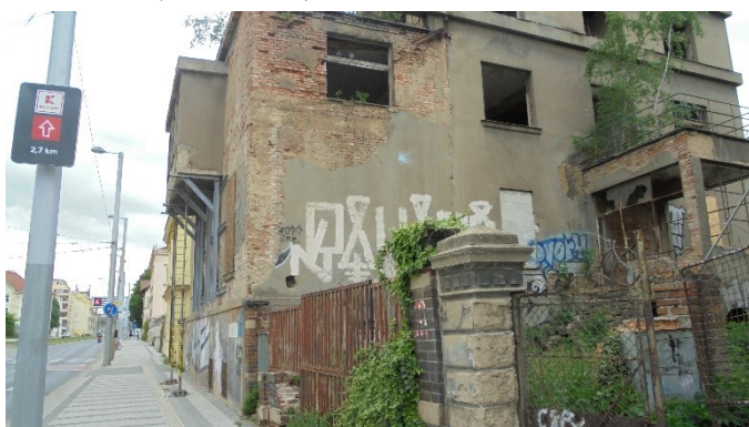
Obrázek 5.1.5: Degradované vily přilehlé na ulici Milady Horákové (6. 5. 2020)
