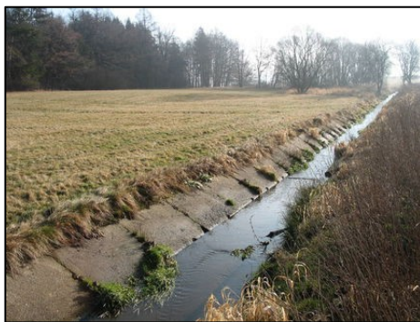
Obr. 4: Silně opevněné a degradované koryto vodního toku ve tvaru typického melioračního lichoběžníku (Zdroj: AOPK 2020)
