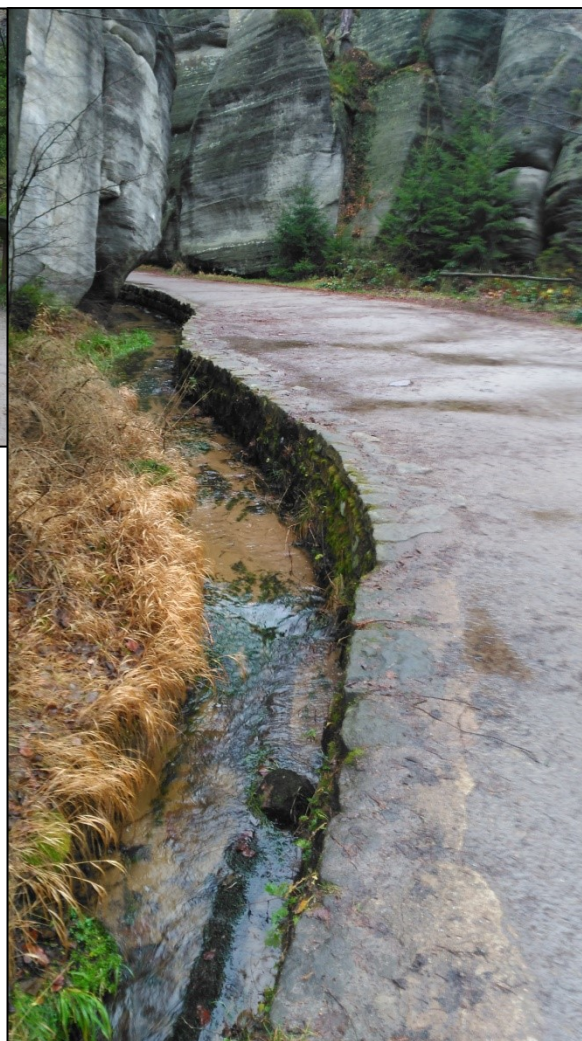
Obr. 35: Zpevněný břeh ve stejném úseku, tentokrát ale kamennou dlažbou, úsek MET016 (Foto: dílo autora)
