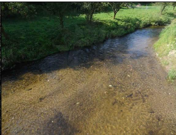
Obr. 39: Zúžení toku na konci obce Česká Metuje po jeho zkapacitnění v jejím centru, úsek MET001 (Foto: Černý, převzato z reka-metuje.sije.cz 2019)
