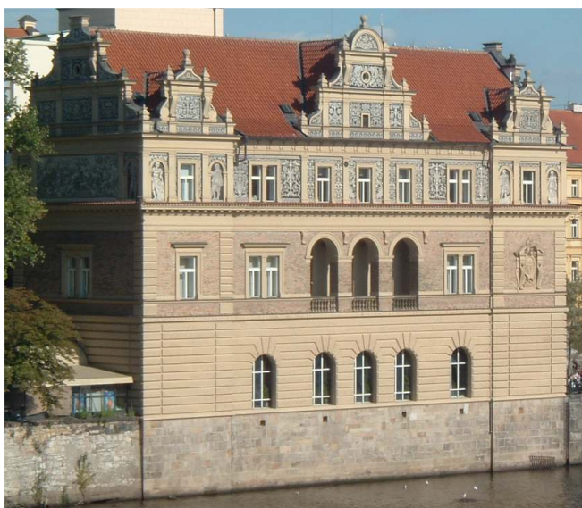
42) Staroměstská vodárny, Praha
