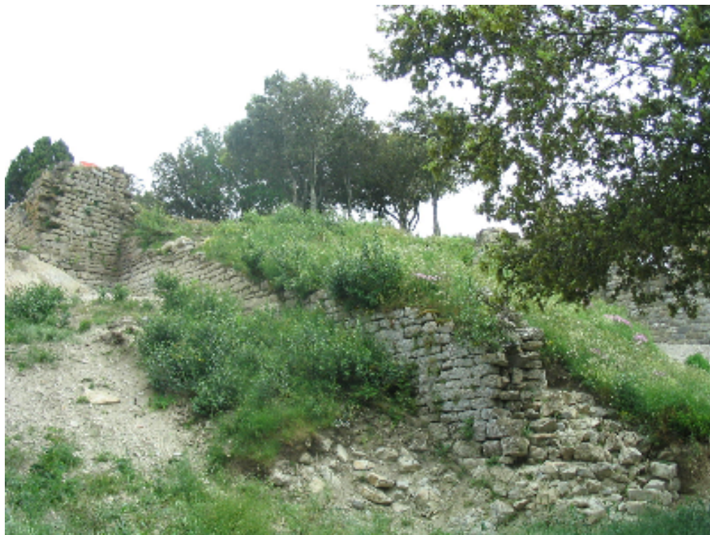
Termes - přibližně v těchto místech měla stát hradní cisterna, jenž sehrála rozhodující úlohu v bojích o hrad...
