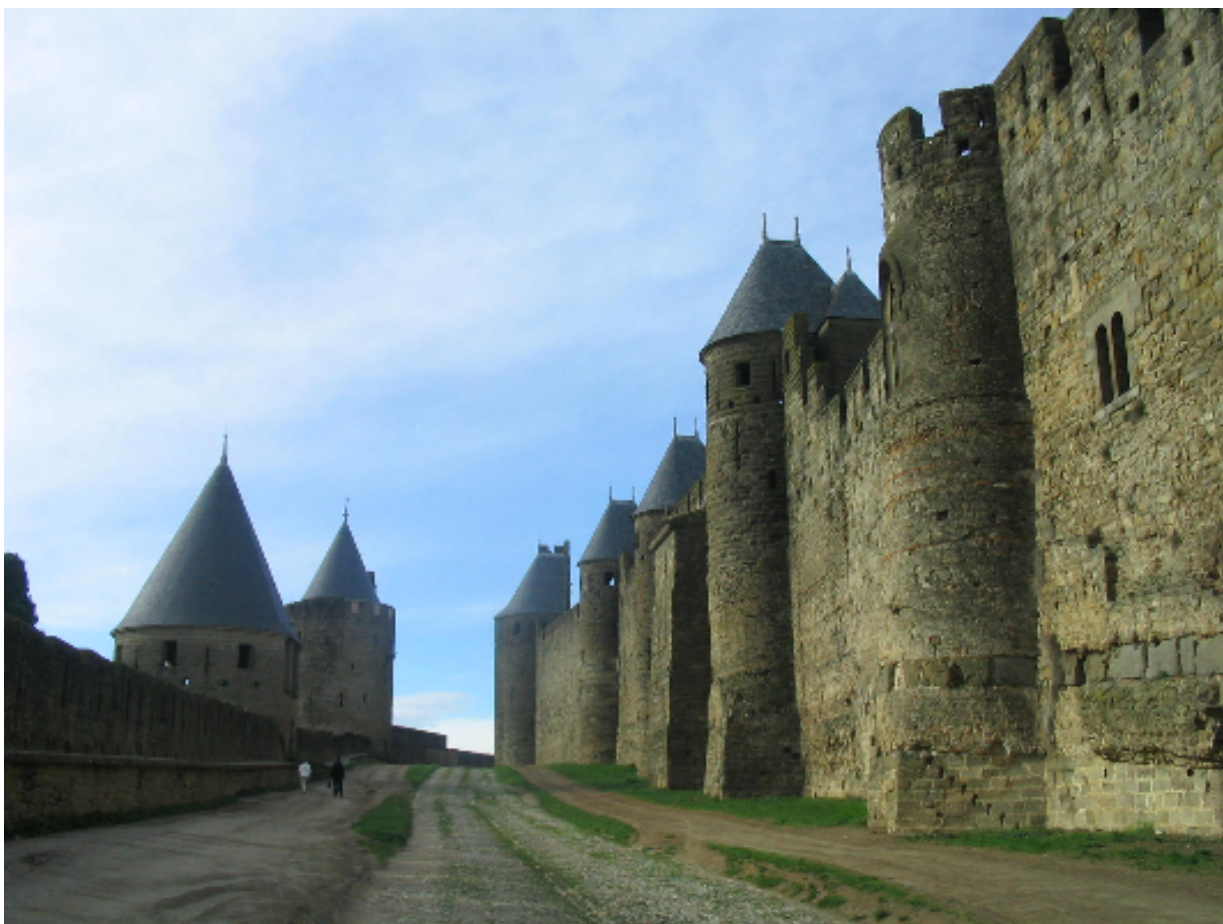
Parkán před hradbami starého města ( Cité ) Carcassonne. V době válek proti albigenským stál pouze vnitřní pás hradeb (vpravo), parkán a vnější pás hradeb s baštami (vlevo) byly přistavěny za vlády Ludvíka IX Svatého.
